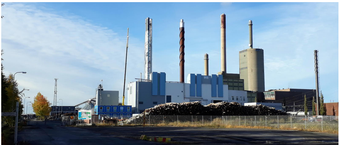
Wärtsilä Finland Oy:n Vaskiluoto Engine Laboratory ja takana Vaskiluodon Voima Oy
