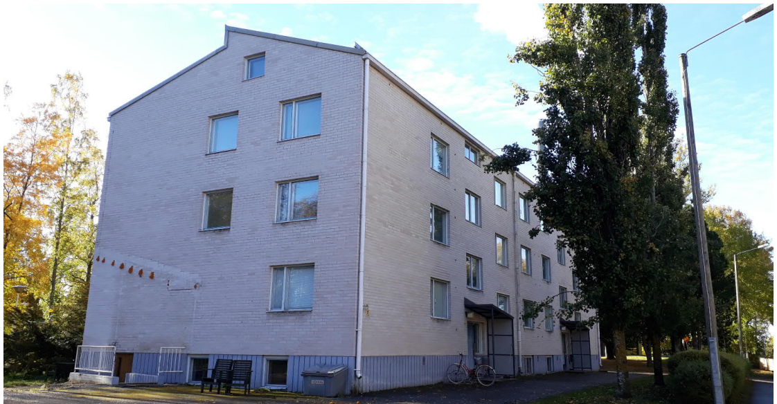
Frilundintie 7 (3), rakennus jolla on purkulupa
