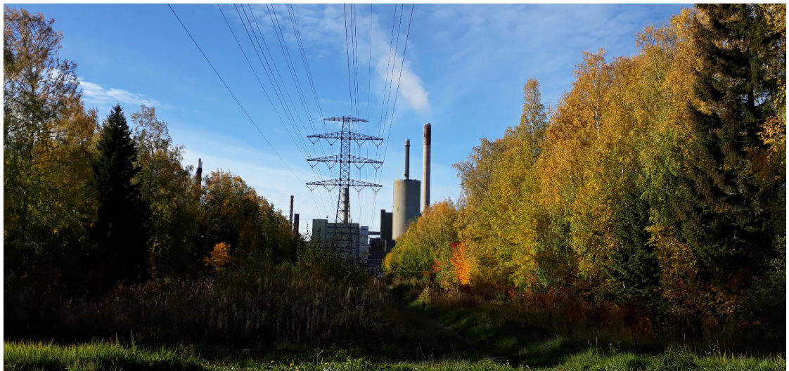
Alueen halki kulkee kadun alle siirrettävä voimalinja ja polku Kuulahden rantaan
