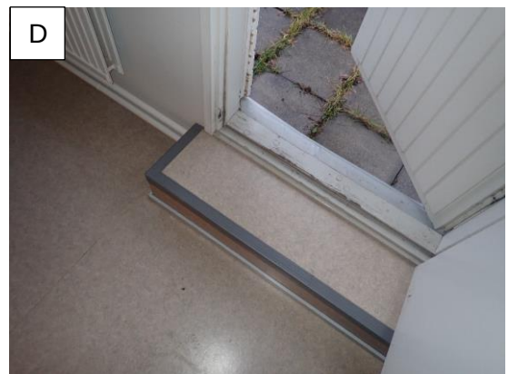
Kuvat 6 A ... D. Rakennuksissa ei ole syöksytorvien alla sadevesikaivoja (A). Rinne- maastosta ja rakennustavasta johtuen ulkoseinä- ja lattia rakenteet ovat monin paikoin reilusti maanpinnan alapuolella (B, C ja D).
