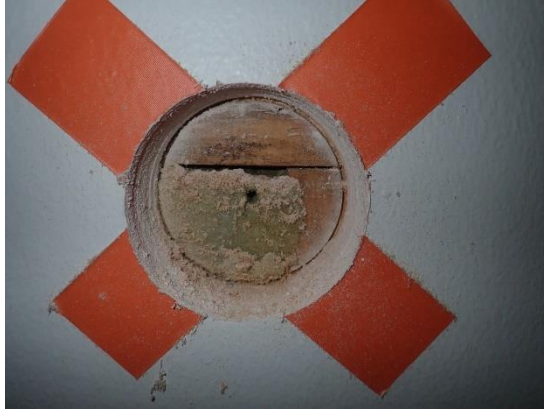
Kuva 28. Rakenneavaus RAK 8 huoneiston H39 ulkoseinärakenteeseen 2.kerroksen ikkunan alle.
