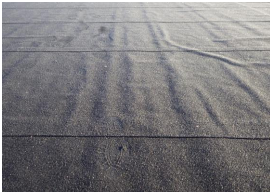
Kuva 43. Kermien välisissä saumoissa ei havaittu riittävästi bitumimassaa.
