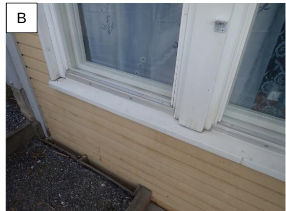
Kuvat 22 A ja B. Julkisivujen pellityksissä havaittiin lukuisia vesitiiviyspuutteita liitospellityksissä. (A) Ikkunoiden vesipellitysten kaadot ovat pääsääntöisesti loivia. Nykymääräysten mukaan kaato tulee olla vähintään 1:3 (B).
