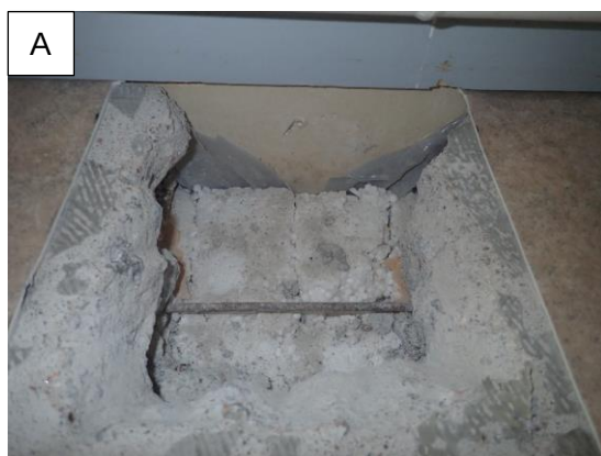
Kuvat 12 A ja B. Rakenneavaus RAK1 huoneistossa Q23. Avauksesta todettiin aistin-varaisesti arvioituna mikrobiperäistä hajua. Lattia- ja seinärakenteen liitoskohdasta kipsilevystä otettiin näyte (A5) mikrobianalyysiin. (Epäily mikrobikasvusta materiaalissa). Puun kosteudenmittalaitteella alaohjauspuun yläpinnasta puun kosteudeksi mitattiin 10 paino-%.
