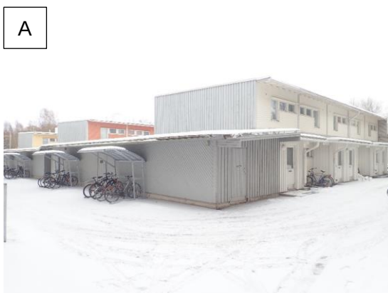
Kuvat 17 A ja B. Pääty julkisivuista osa on toteutettu pystylomalaudoituksella.
