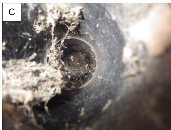
Kuvat 45 A...C. Vanhan ja uuden bitumikermien väliin asennettu tuuletusputki.
