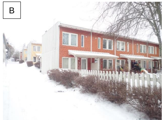
Kuvat 19 A ja B. Pääty julkisivuista osa on toteutettu pystylomalaudoituksella.
