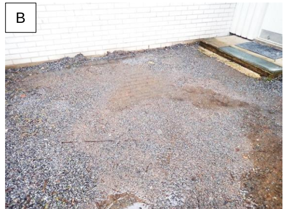
Kuvat 5 A ja B. Aistinvaraisesti tarkasteltuna piha-alueiden maanpintoja ei ole muotoiltu rakennusten välittömästä läheisyydestä rakennuksista poispäin viettäväksi. Puurakenteiset julkisivumateriaalit ovat hyvin lähellä maan pintaa tai jopa sen alapuolella.
