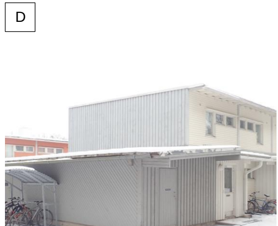
Kuvat 33 A...D. Yläpohjatilan tuuletus on heikko. Räystäällä on havaittavissa 10 – 20 mm tuuletusrako.
