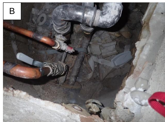
Kuvat 12 A ja B. Kuvat huoneiston B6 keittiössä olevasta putkikanaalin tarkastuskai- vosta. Kaivosta aistittiin voimakasta maaperän hajua ja sieltä todettiin merkkisavulla tarkasteltuna ilmavirtausta sisäilmaa kohti.
