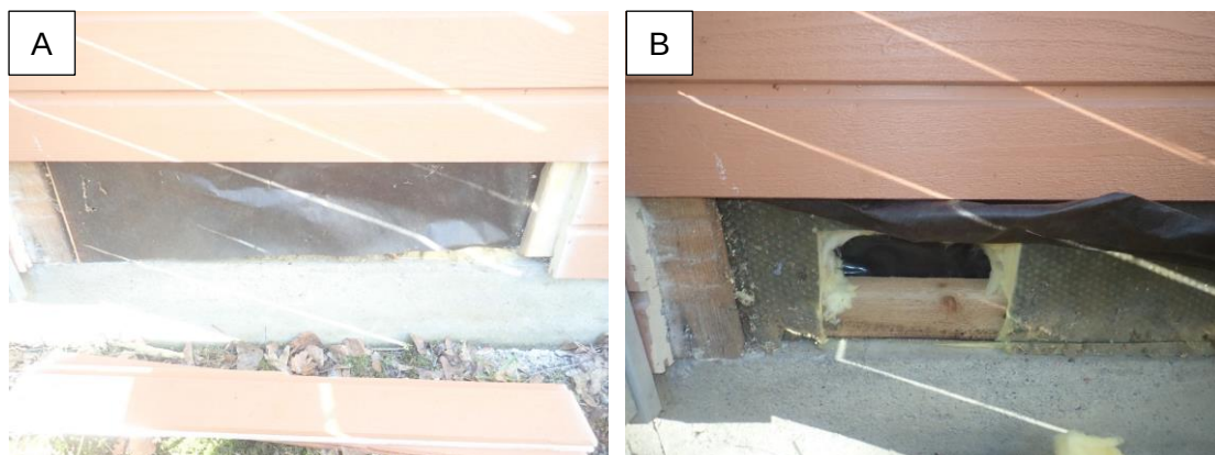
Kuvat 24 A ja B. Rakenneavaus RAK 4 huoneiston Y71 ulkoseinärakenteeseen (pitkä sivu).
