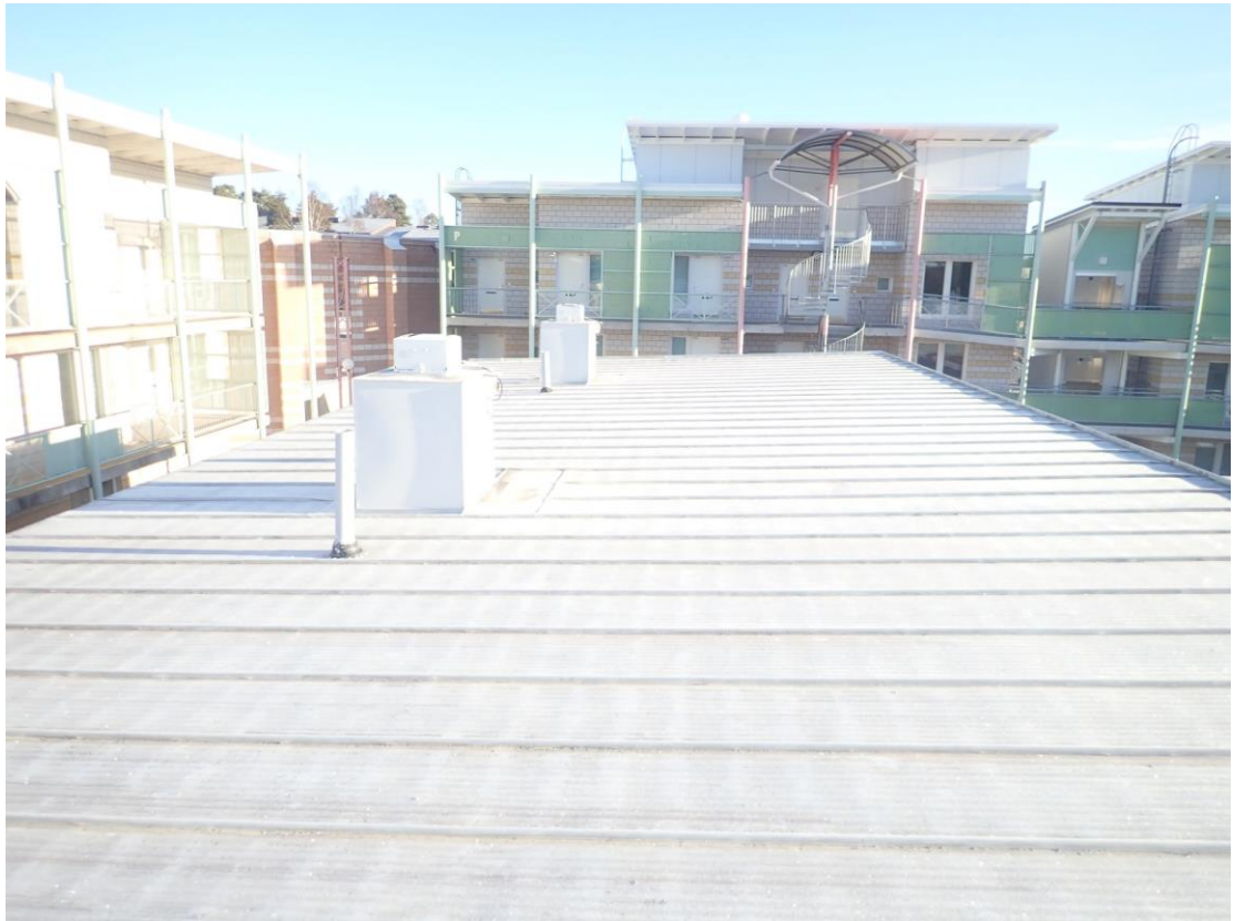
Kuva 30. Yleiskuva O-talon vesikatolta.
