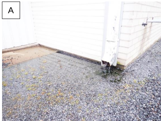
Kuvat 5 A ja B. Aistinvaraisesti tarkasteltuna piha-alueiden maanpintoja ei ole muotoiltu rakennusten välittömästä läheisyydestä rakennuksista poispäin viettäväksi. Puurakenteiset julkisivumateriaalit ovat hyvin lähellä maan pintaa tai jopa sen alapuolella.
