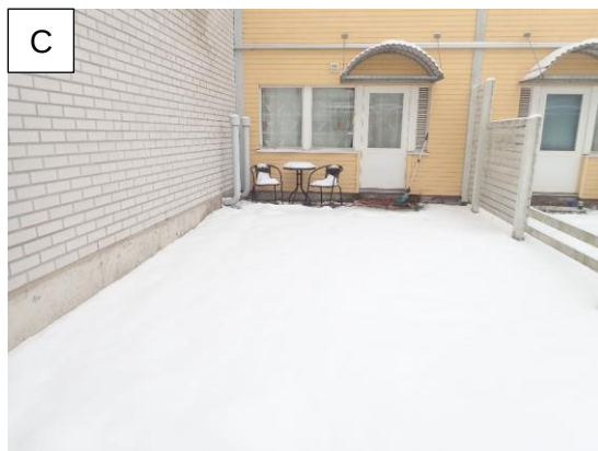
Kuvat 6 A ... D. Rakennuksissa ei ole syöksytorvien alla sadevesikaivoja (A). Rinne- maastosta ja rakennustavasta johtuen ulkoseinä- ja lattia rakenteet ovat monin paikoin reilusti maanpinnan alapuolella (B, C ja D).
