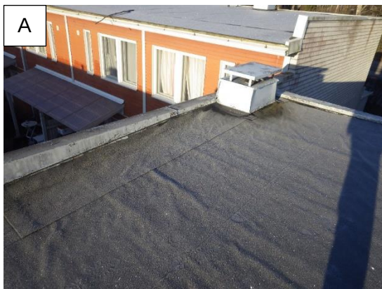
Kuva 43. Kermien välisissä saumoissa ei havaittu riittävästi bitumimassaa.
