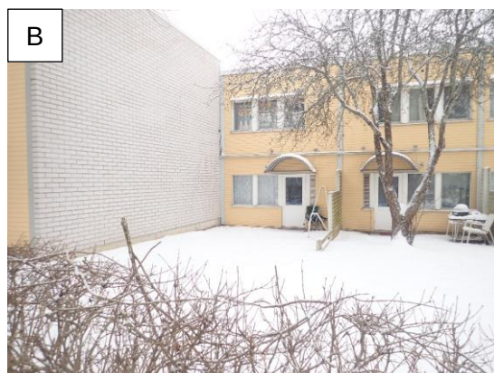
Kuvat 17 A ja B. Pääty julkisivuista osa on toteutettu pystylomalaudoituksella.
