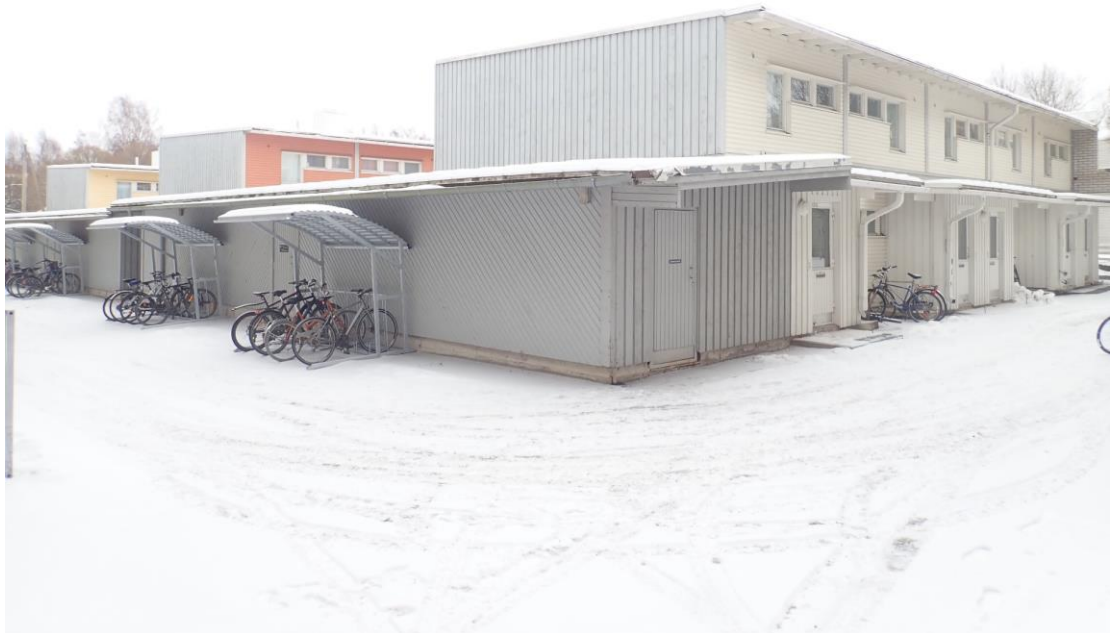
Kuva 4. Rakennukset sijaitsevat loivassa rinteessä.
