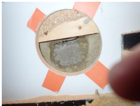
Kuva 27. Rakenneavaus RAK4 huoneiston H39 lattiakorotuksen puukoolatulta osuudelta.
