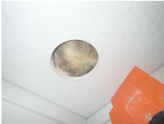
Kuva 29. Rakenneavaus RAK3 huoneiston X70 yläpohjarakenteeseen.
