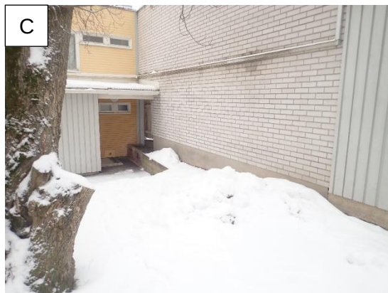
Kuvat 6 A ... C. Rinnemaastosta ja rakennustavasta johtuen ulkoseinä- ja lattiarakenteet ovat monin paikoin reilusti maanpinnan alapuolella. Rakenteiden kosteusrasitusta on paikoin pyritty vähentämään esimerkiksi vesivanerilevytyksillä tehdyillä tuuletusväleillä. "Tuuletusvälissä" kasvaa puita. Maanpinta viettää melko jyrkästi kohti ulkoseinää, ohjaten sade- ja sulamisvedet kohti rakennusta.
