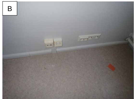
Kuvat 37 A ja B. Huoneiston sähkökeskus on uusittu peruskorjauksen yhteydessä (A). Sähköistystä on ainakin osittain uusittu peruskorjausten yhteydessä (B).
