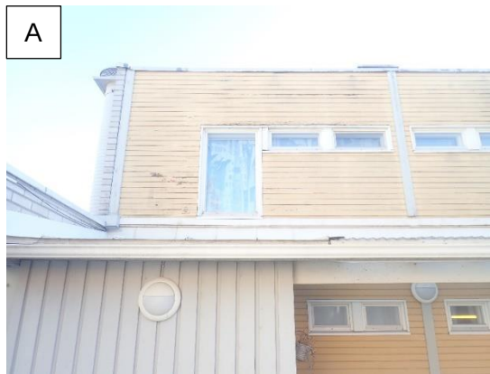
Kuvat 21 A ja B. Rästäättömyys lisää julkisivujen kosteusrasitusta merkittävästi.
