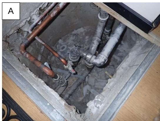
Kuvat 12 A ja B. Kuvat huoneiston B6 keittiössä olevasta putkikanaalin tarkastuskai- vosta. Kaivosta aistittiin voimakasta maaperän hajua ja sieltä todettiin merkkisavulla tarkasteltuna ilmavirtausta sisäilmaa kohti.
