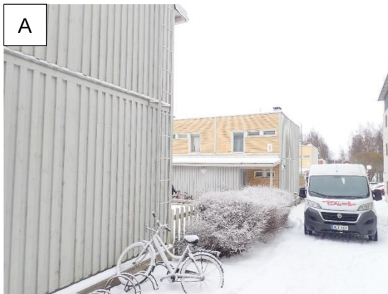
Kuvat 19 A ja B. Pääty julkisivuista osa on toteutettu pystylomalaudoituksella.
