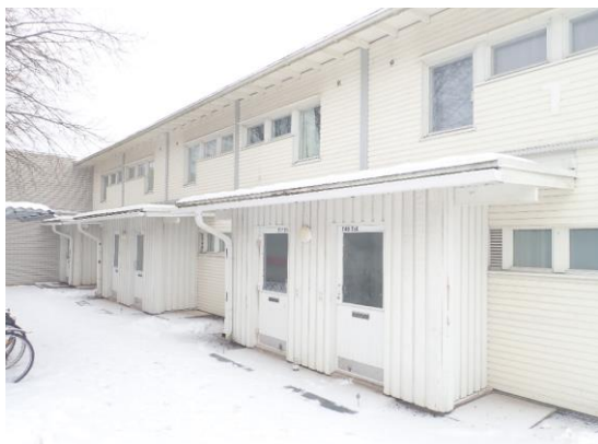
Kuva 35. Rakennusten eteistilat on uudelleen rakennettu 2000-luvun peruskorjauksen yhteydessä.
