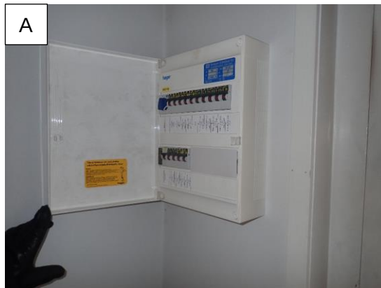
Kuvat 37 A ja B. Huoneiston sähkökeskus on uusittu peruskorjauksen yhteydessä (A). Sähköistystä on ainakin osittain uusittu peruskorjausten yhteydessä (B).
