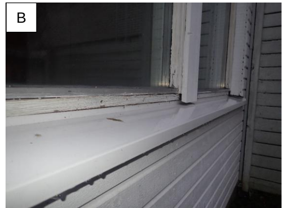
Kuvat 21 A ja B. Julkisivujen pellityksissä ja läpivienneissä havaittiin lukuisia vesitiiviyyspuutteita (A) Ikkunoiden vesipellitusten kaadot ovat pääsääntöisesti loivia. Nykymääräysten mukaan kaato tulee olla vähintään 1:3.
