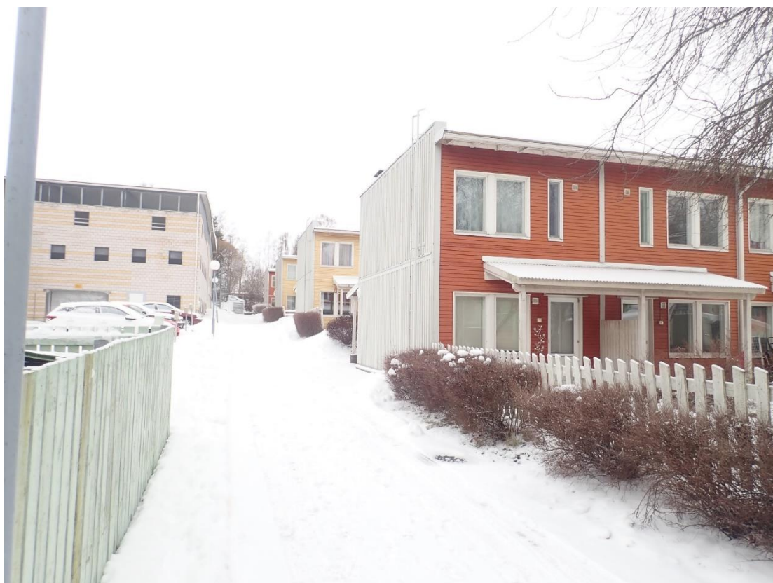
Kuva 4. Rakennukset sijaitsevat loivassa rinteessä.
