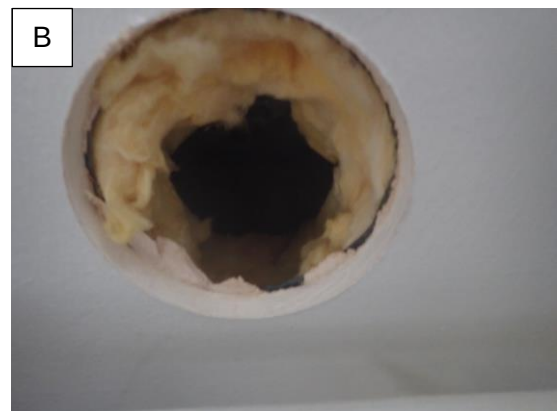
Kuvat 23 A ja B. Rakenneavaus RAK2 huoneiston X69 ulkoseinärakenteeseen (pitkä sivu). Kipsilevyn takapinnassa havaittiin valumajälkiä.
