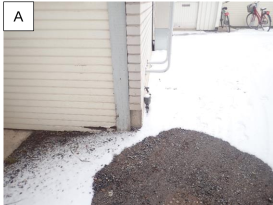
Kuvat 5 A ja B. Aistinvaraisesti tarkasteltuna piha-alueiden maanpintoja ei ole muotoiltu rakennusten välittömästä läheisyydestä rakennuksista poispäin viettäväksi. Puurakenteiset julkisivumateriaalit ovat hyvin lähellä maan pintaa tai jopa sen alapuolella.
