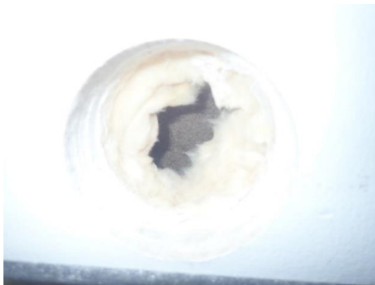
Kuva 29. Rakenneavaus RAK 9 huoneiston B6 ulkoseinärakenteeseen (päätyseinä).
