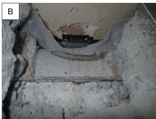
Kuvat 12 A ja B. Rakenneavaus RAK1 huoneistossa Q23. Avauksesta todettiin aistin-varaisesti arvioituna mikrobiperäistä hajua. Lattia- ja seinärakenteen liitoskohdasta kipsilevystä otettiin näyte (A5) mikrobianalyysiin. (Epäily mikrobikasvusta materiaalissa). Puun kosteudenmittalaitteella alaohjauspuun yläpinnasta puun kosteudeksi mitattiin 10 paino-%.
