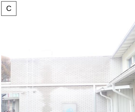
Kuvat 33 A...D. Yläpohjatilan tuuletus on heikko. Räystäällä on havaittavissa 10 – 20 mm tuuletusrako.
