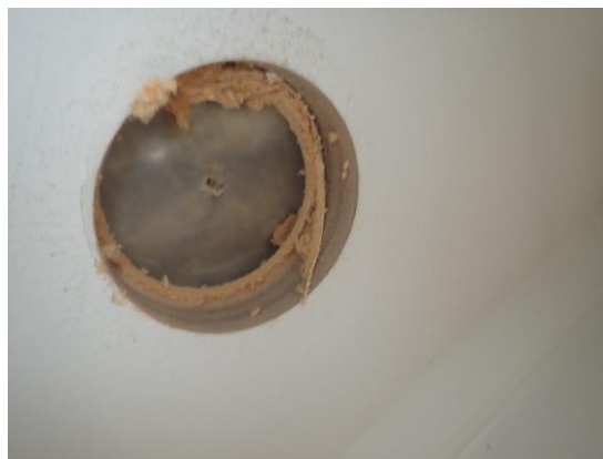
Kuva 40. Rakenneavaus RAK5 huoneiston H39 yläpohjarakenteeseen.
