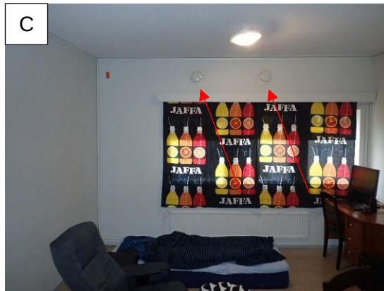
Kuvat 36 A...C. Yleiskuva keittiöstä (A) ja yleiskuva pesuhuoneesta (B). Huoneistojen ilmanvaihtotapana on koneellinen poisto, jota ohjataan liesituulettimesta. Korjausilma-venttiilit ovat oleskelutiloissa (C).
