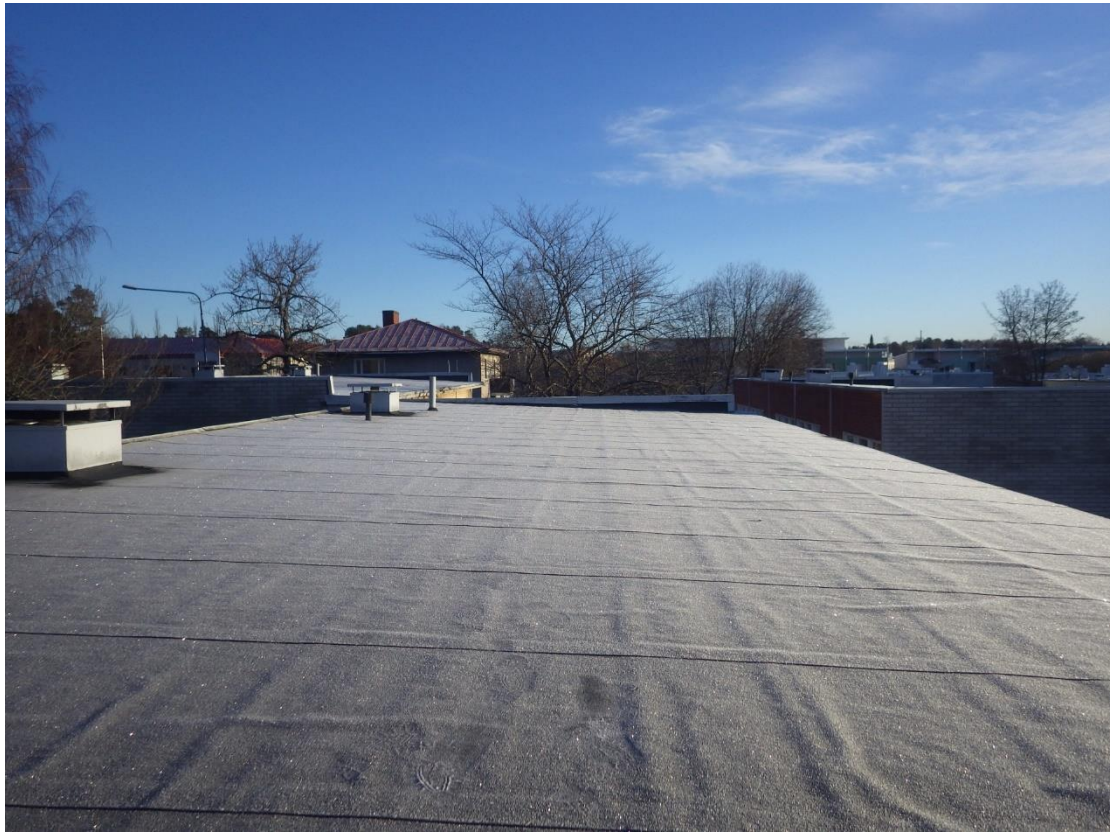
Kuva 42. Yleiskuva B-talon vesikatoilta.
