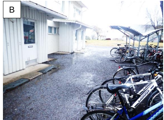
Kuvat 5 A ja B. Aistinvaraisesti tarkasteltuna piha-alueiden maanpintoja ei ole muotoiltu rakennusten välittömästä läheisyydestä rakennuksista poispäin viettäväksi. Puurakenteiset julkisivumateriaalit ovat hyvin lähellä maan pintaa tai jopa sen alapuolella.
