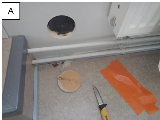
Kuvat 23 A ja B. Rakenneavaus RAK2 huoneiston X69 ulkoseinärakenteeseen (pitkä sivu). Kipsilevyn takapinnassa havaittiin valumajälkiä.
