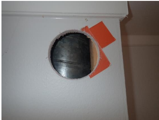
Kuva 41. Rakenneavaus RAK6 huoneiston H39 pystykotelorakenteeseen.
