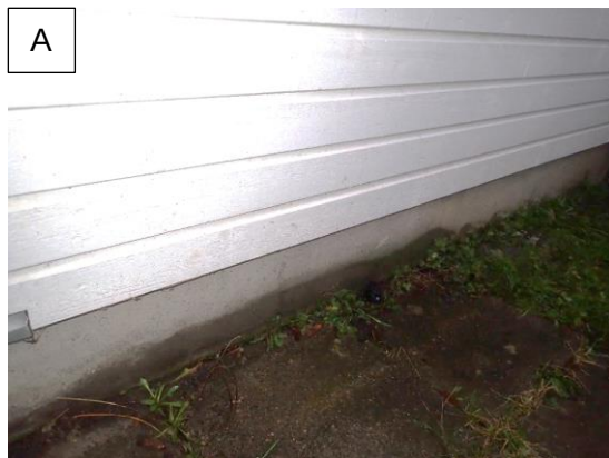
Kuvat 11 A ja B. Valesokkelirakenteesta voi ulkopuolelta päätellä, että alaohjauspuu on maanpinnan tason alapuolella (A). Lattian yläpinnan taso on hyvin lähellä maanta-soa tai jopa sen alapuolella (B).
