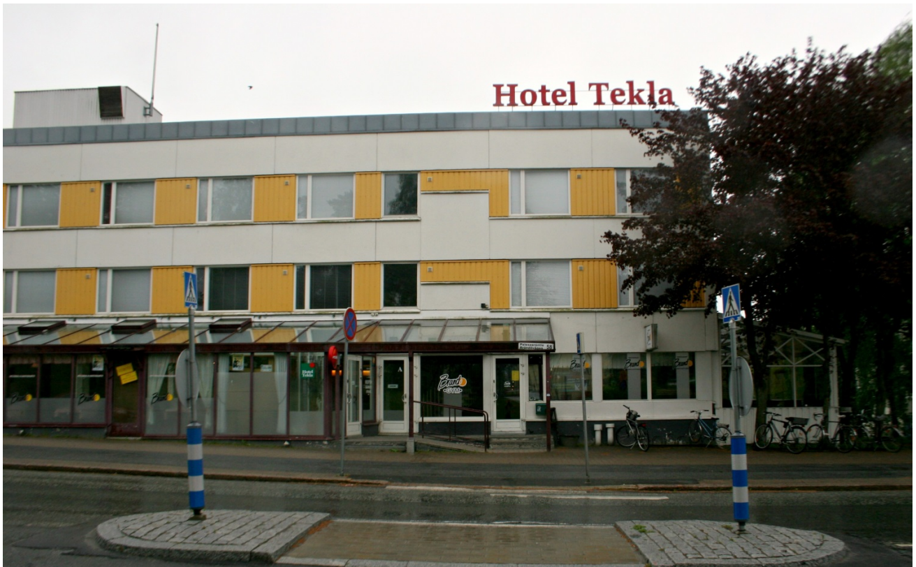
Tekla I, 1968. Julkisivu Palosaarentielle (kuvattu toukokuussa 2014).
