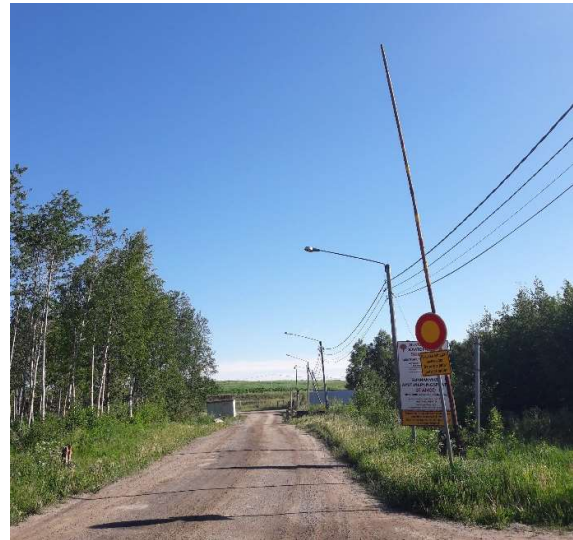
Kaatopaikan portin vanha puomi.
