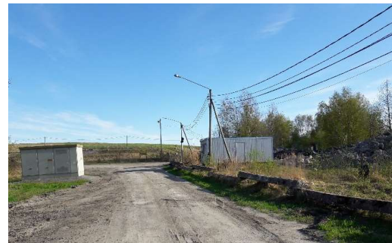
Betonirakenteet tien oikealla puolella.
