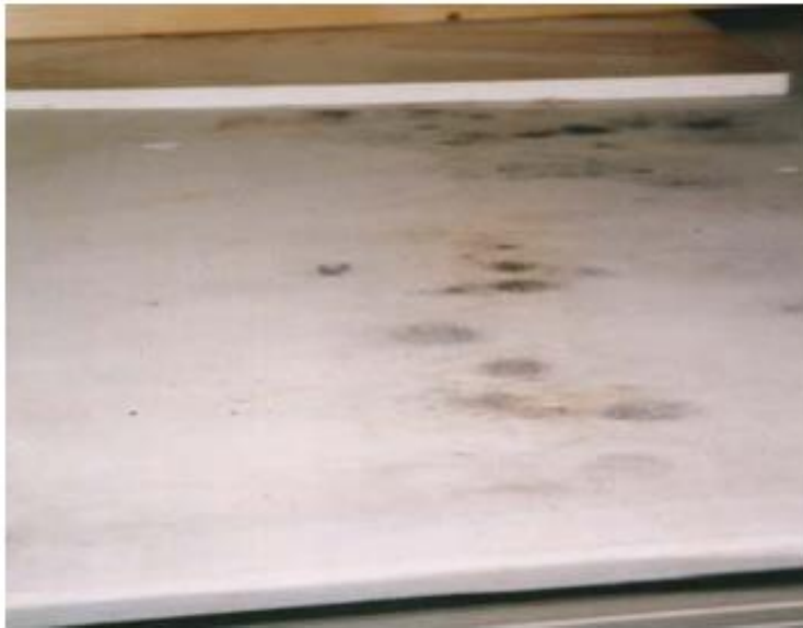
Bild 1 Mögelfläckar på papp (kartongen) Bild 2 Rinningsmärken på skivorna
