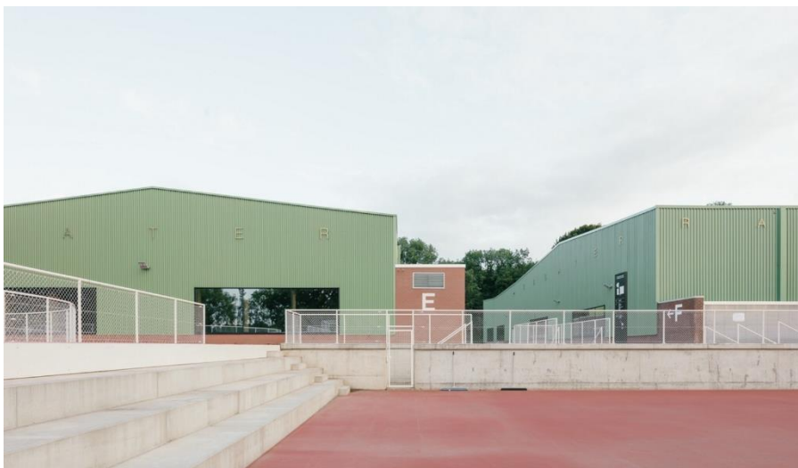
Kuva 48 Love pt. II Sports Facilities (Charleroi, Belgia) toisintaa teollisuusrakennuksista tuttua estetiikkaa. Suunnittelija Label Architecture, valokuva Stijn Bollaert
