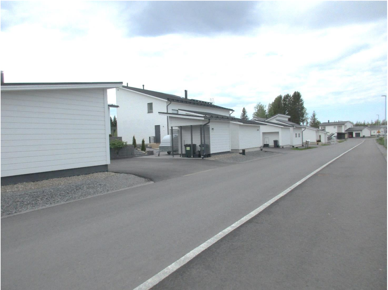
Kuva 2. Hiilloskujan eteläpuolella olevaa rakennuskantaa.
