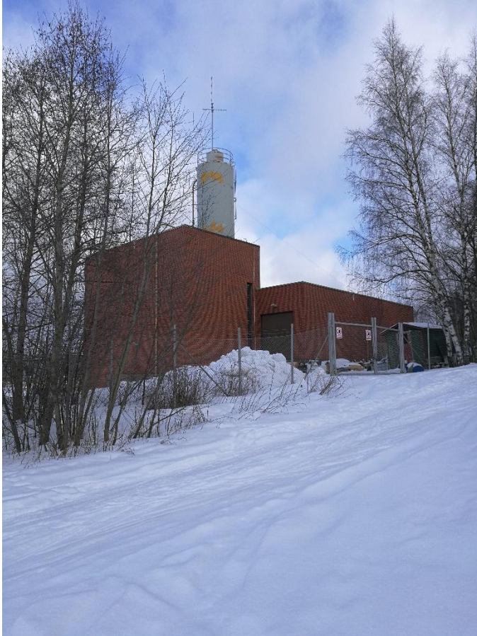
Kuva 2. Varalinko rakennuksen katolla
