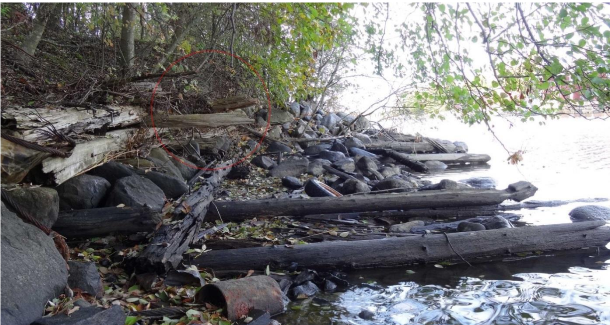
Kuva 27. Hirsiarkun veden yläpuoliset osat kuvassa vasemmalla ovat kuivuneet ja lahonneet. Ne jatkuvat rantapenkan sisään. Kuvaan on ympyröity penkasta törröttävät hirret. Kuvaussuunta on pohjoiseen.
