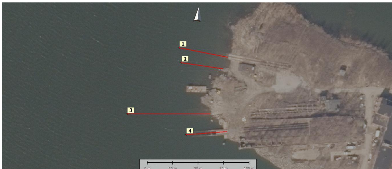
Kuva 16. Ilmakuva telakan ympäristöstä ja raiteiden sijainti vedessä.
