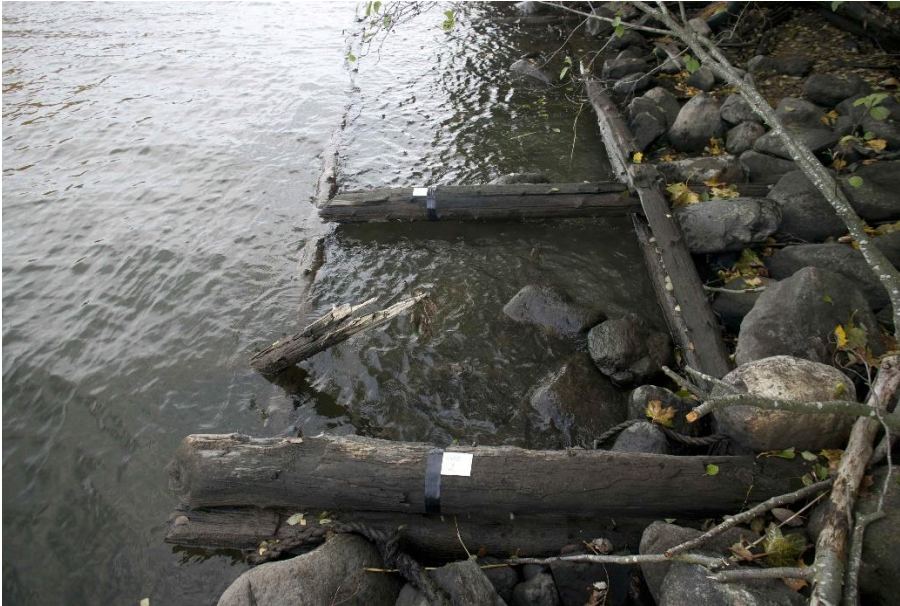
Kuva 32. Näytteiden 1 ja 2 sijainti hirsiaarkkurakenteessa ennen näytteenottoa. Näytteet on merkitty teipillä ja valkoisella kylteillä kuvassa poikittain oleviin hirsiiin. Etualalla on näytehirsi numero 2 ja taaempaa näytehirsi numero 1. Kuvaussuunta on etelään, kohti makasiinirakennusta.
