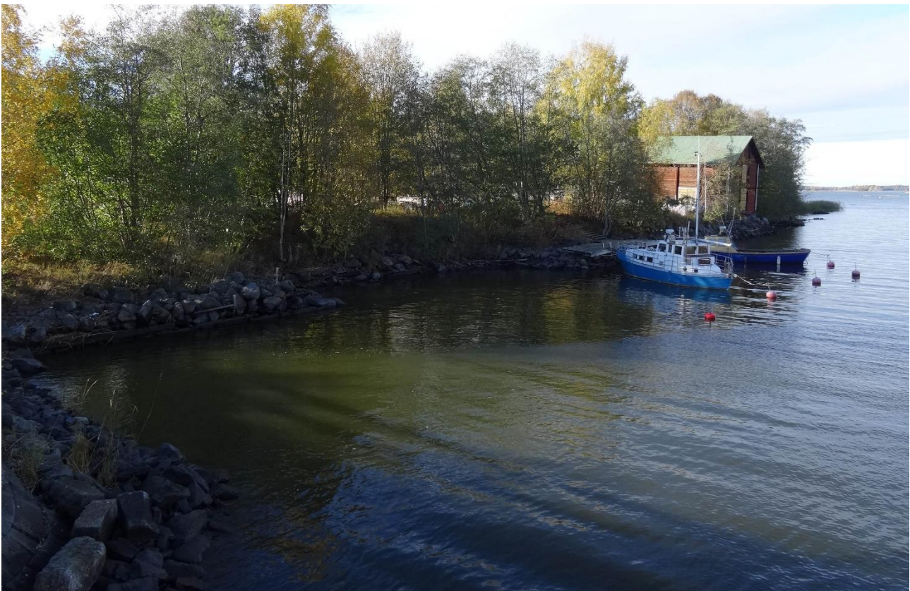
Kuva 19. Kuva on otettu Mansikkasaaren johtavalta sillalta luoteeseen. Kuvan vasemmassa alareunassa näkyy sillan perustukseen liittyvää rakennetta. Itse saaren rannassa voidaan havaita hirsiarkuille perustettua rantaa sekä arkkuperustainen laituri, jossa veneet ovat kiinni. Rantaan muodostuu suorakaiteenmuotoisia ulkonemia. Taustalla näkyy makasiini, jonka pohjoispuolella hirsiarkkurakenteet jatkuvat.
