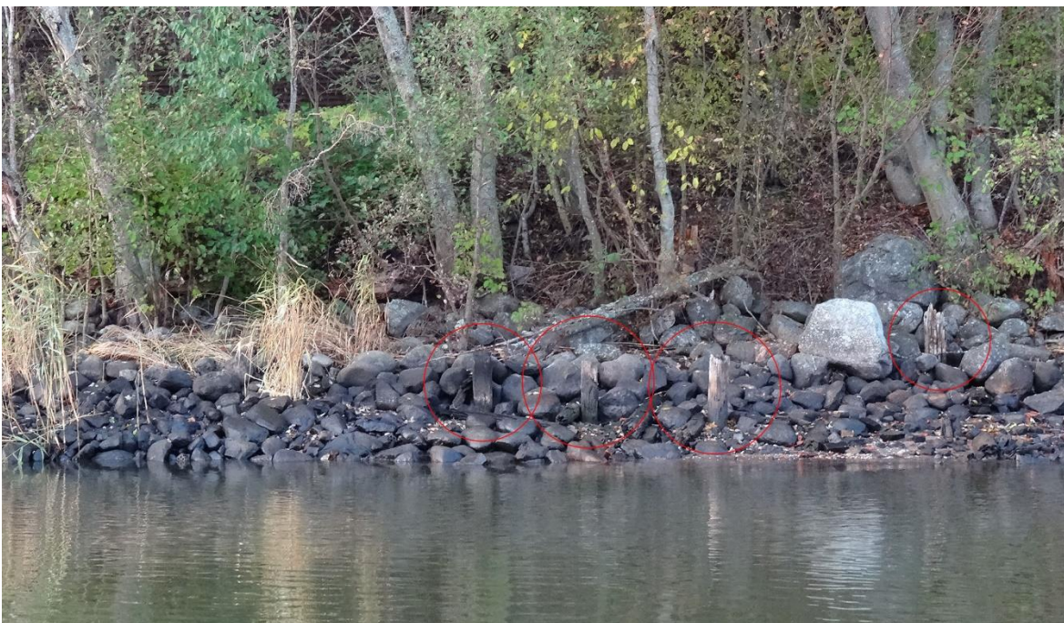
Kuva 32. Hirsiarkkurakenne sijaitsee kuvan ulkopuolella vasemmalla. Rannassa on näkyvissä neljä pystypaalua, joiden alla kivikon sisällä on rantapenkan sisälle jatkuvia hirsii. Paalut on ympyröity kuvaan punaisella. Kuvaussuunta on länteen.
