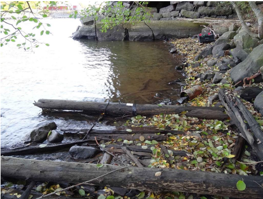
Kuva 33. Näytteen 3 sijainti hirsiaarkkurakenteessa ennen näytteenottoa. Näyte on merkitty teipillä ja valkoisella kyltillä kuvassa poikittain olevaan hirtehen. Kuvaussuunta on etelään, kohti makasiinirakennusta.
