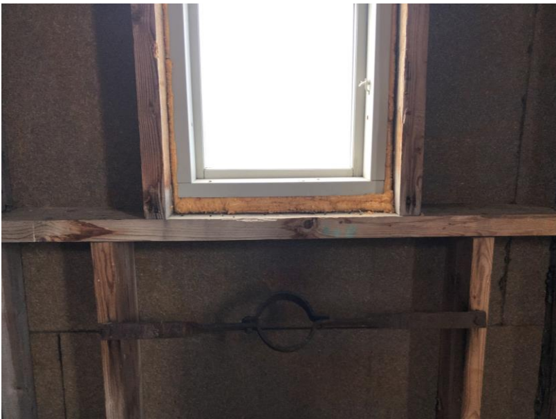
Till vänster: Under fönsterna på sjätte våningen finns stål element som är original. Planläggningen, 2023
