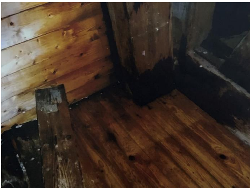
Bild från kallvinden, nedblötta konstruktioner och synliga fuktskador och ytterväggens våta insida, Byggnadsplanering 6.4.2016, Byggnadstillsynen
