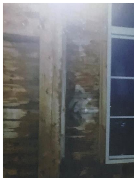
Bild från kallvinden, nedblötta konstruktioner och synliga fuktskador och ytterväggens våta insida, Byggnadsplanering 6.4.2016, Byggnadstillsynen
