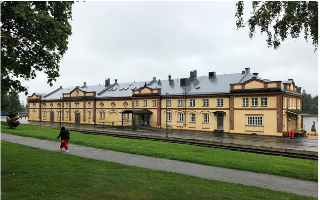
Byggnadens exteriör. Planläggningen, 2023
