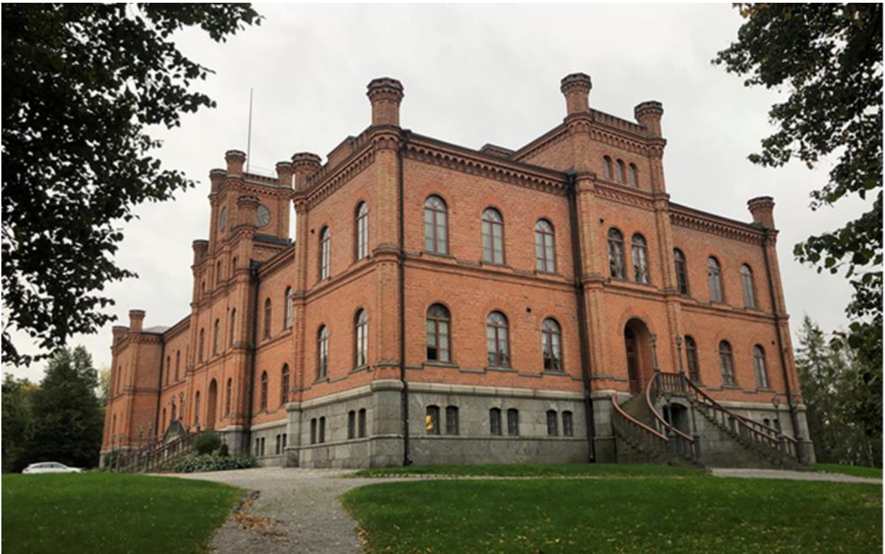
Byggnadens exteriör. Planläggningen, 2023
