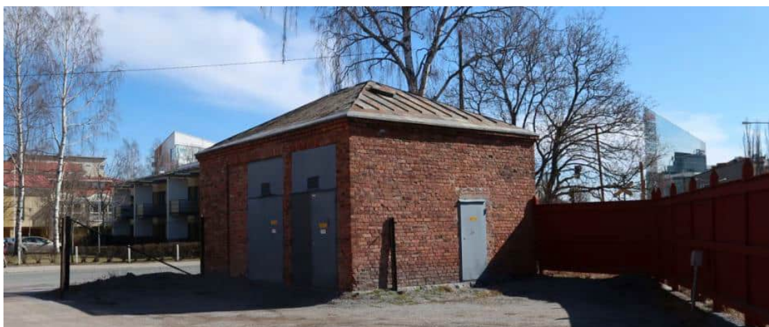
Transformatorbyggnaden fotograferad från Wärtsiläs tomt. Foto: Ramboll.
