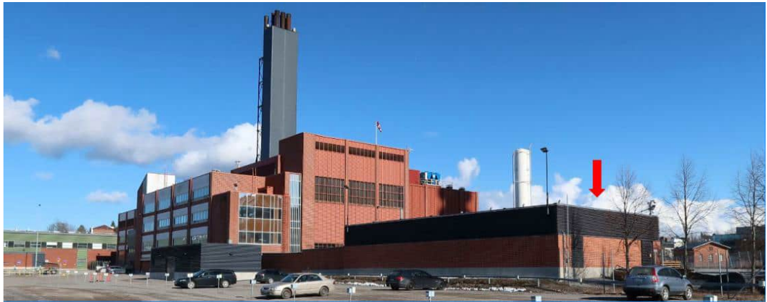
Diesellaboratoriet fotograferat från parkeringsplatsen i väster.
