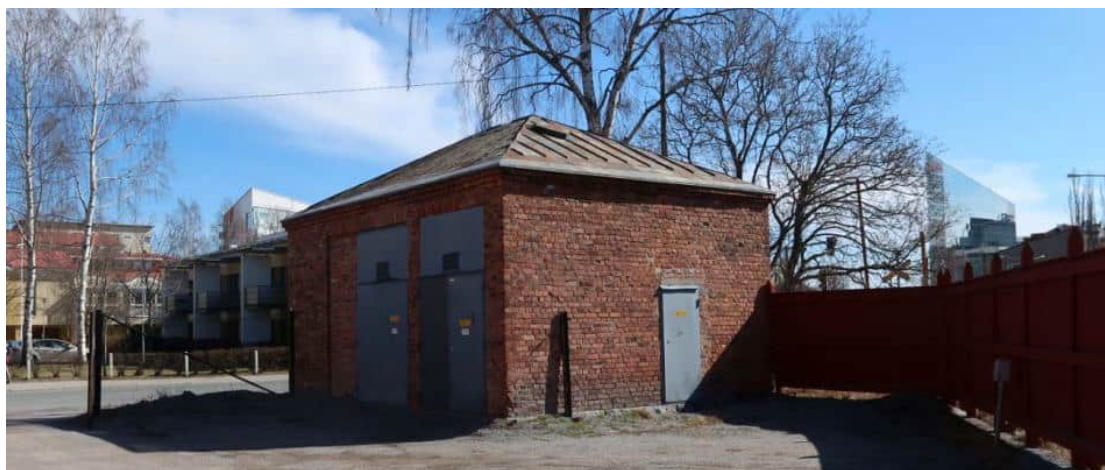
Muuntamo kuvattuna Wärtsilän tontin suunnasta. Kuva: Ramboll.
