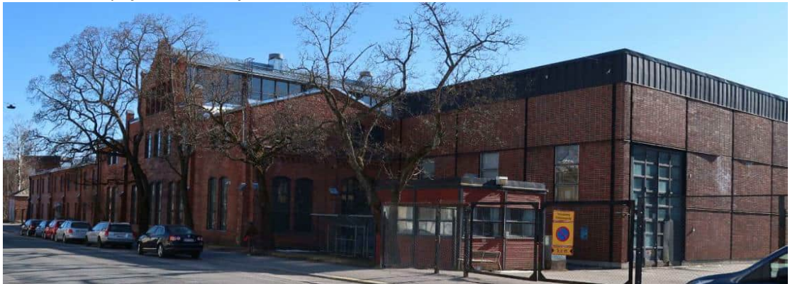
Kiertokankitehdas vuonna 2021. Kuva: Ramboll
