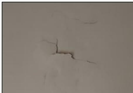
Kuvat 88–89. Taidekodin yksityinen porrashuone, mikä olisi pintaremontin tarpeessa. Yläkerroksen seinän rapautuminen näkyy selvästi.
