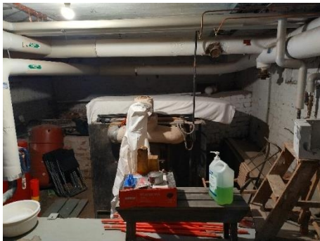
Kuvat 69 ja 70: Pannuhuoneessa on runsaasti talotekniikkaa, vanha koksikattila ei ole enää käytössä, mutta on kokonsa vuoksi jäänyt sijoilleen.
