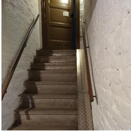
Kuvat 73 ja 74: Pyöräkellariin johtavissa portaissa on pyörän kuljettamista helpottava liuska. Pyöräkel- larissa on myös tilaa muille harrastusvälineille.
