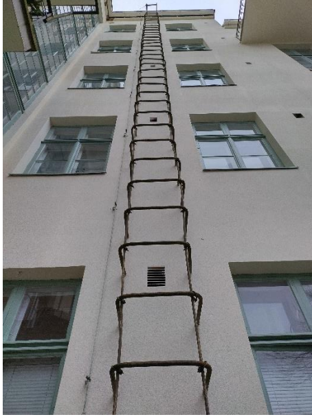
Kuvat 50 ja 51: Metalliset paloportaavat johtavat sisäpihalta katolle. Kuvattu marraskuussa 2022.
