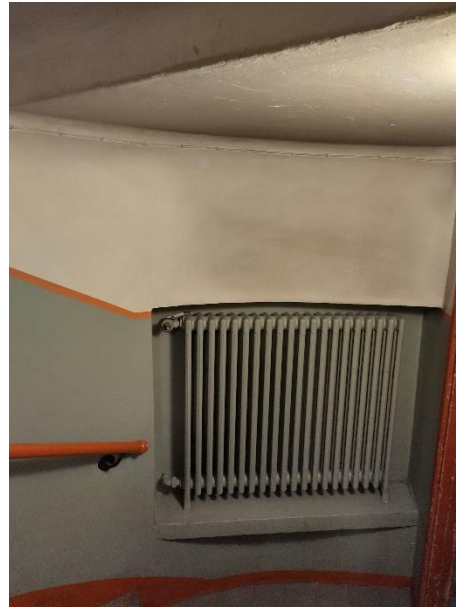
Kuvat 55 ja 56: Kulku a-rapusta kellarin on kaarevan porrashuoneen kautta. Porrashuoneen lämmityspatterit ovat alkuperäiset.
