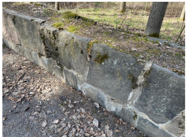
Kivimuurin yksityiskohta, istutusura.
