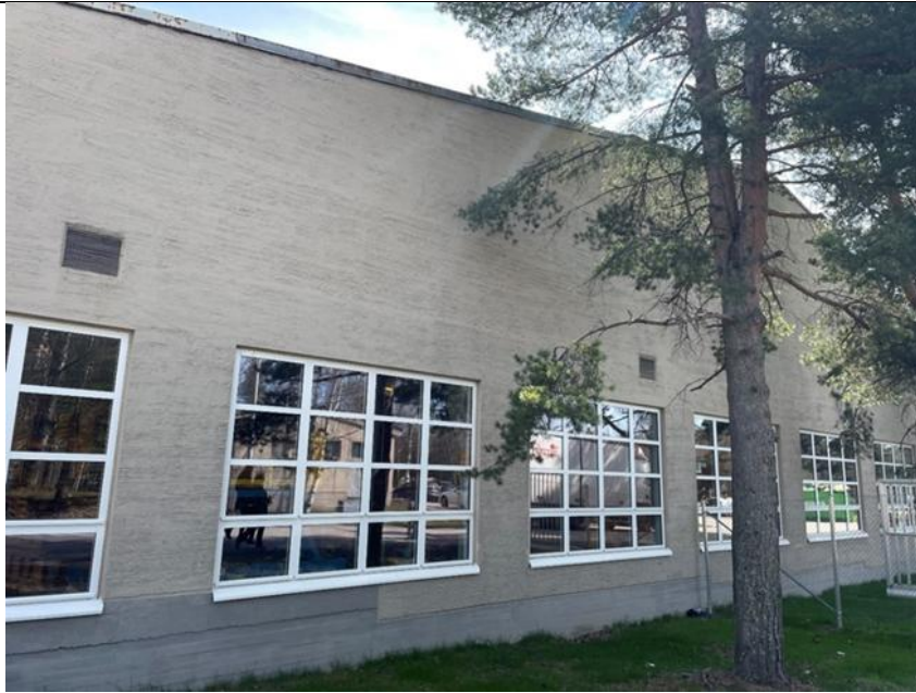
FF, jakelumuuntajan länsipääty.
