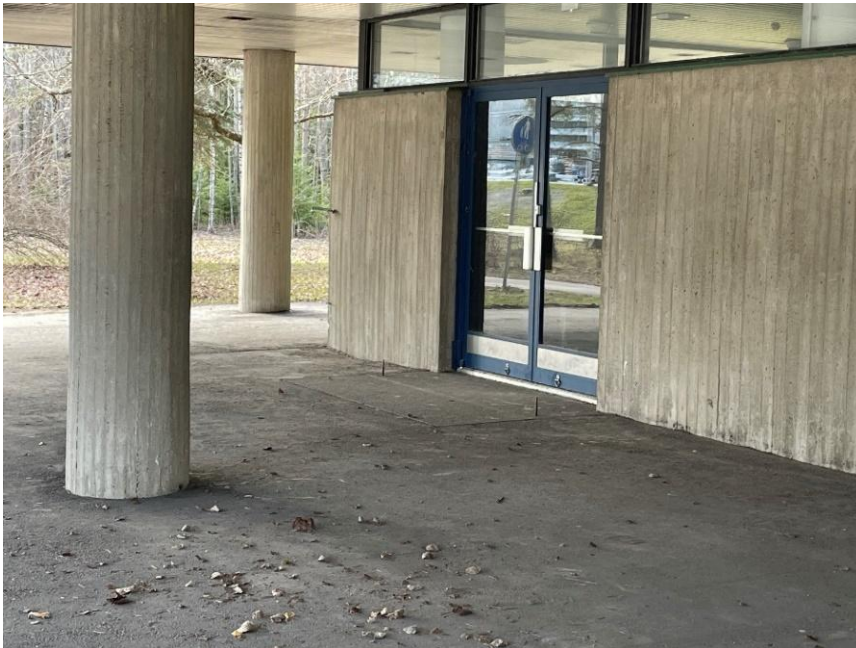
TST, koillispäädyn sisäänkäynti.
