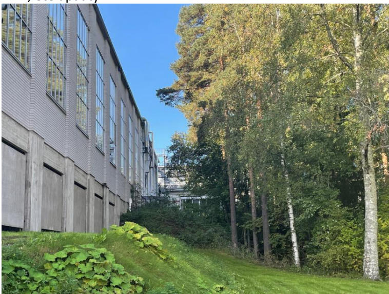
MM, pohjoispääty Sähkömäeltä kuvattuna.
