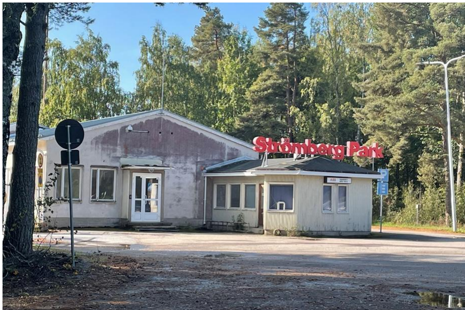
Pohjoisportin ja sosiaalirakennuksen pohjoispääty.
