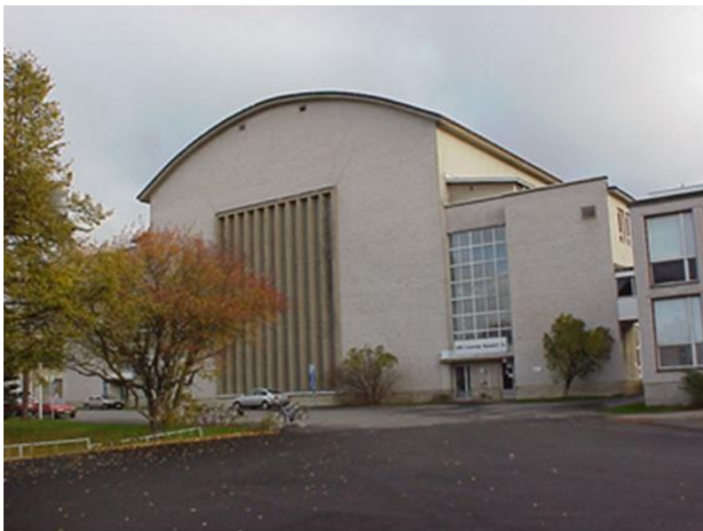
FF, korkeajännitelaboratoriahallin länsijulkisivu.
