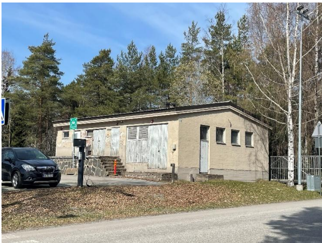
Kaasulaitos, eteläsivu ja itäpääty.
