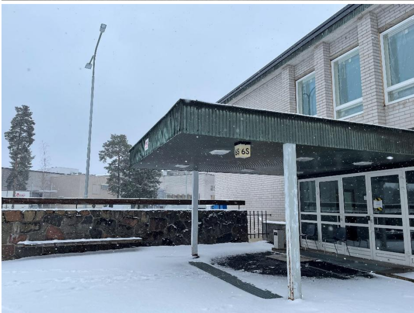
KT, pohjoispäädyn sisääntulo.
