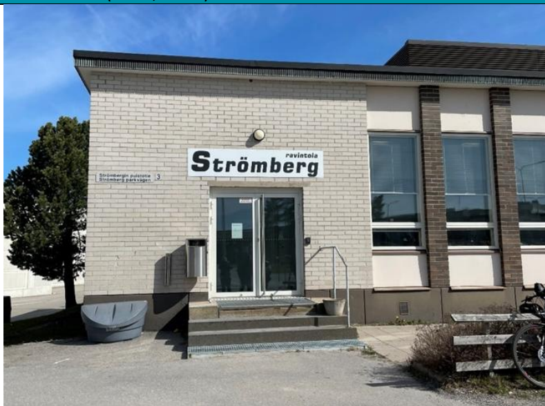
TSR, eteläsivun sisäänkäynti.
