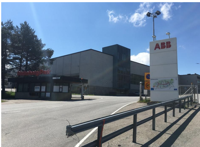
FF, itäisimmän laajennuksen pohjoisjulkisivun sisäänkäynti. Etualalla muuntajaportti.
