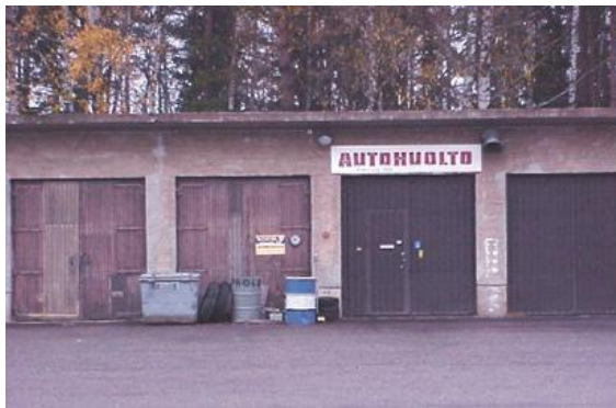
VA, osa lounaissivusta.
