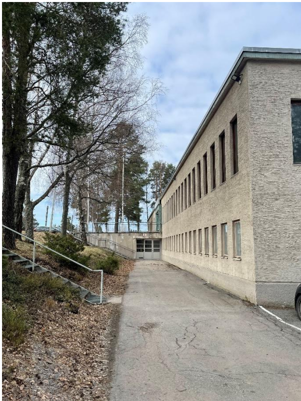
NN, julkisivu sisäpihan puolelta kuvattuna.
