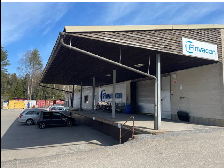
VL, lastausalue rakennuksen länsisivulla.
