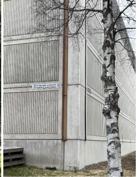
GG, pesemätön ja pesty julkisivu.
