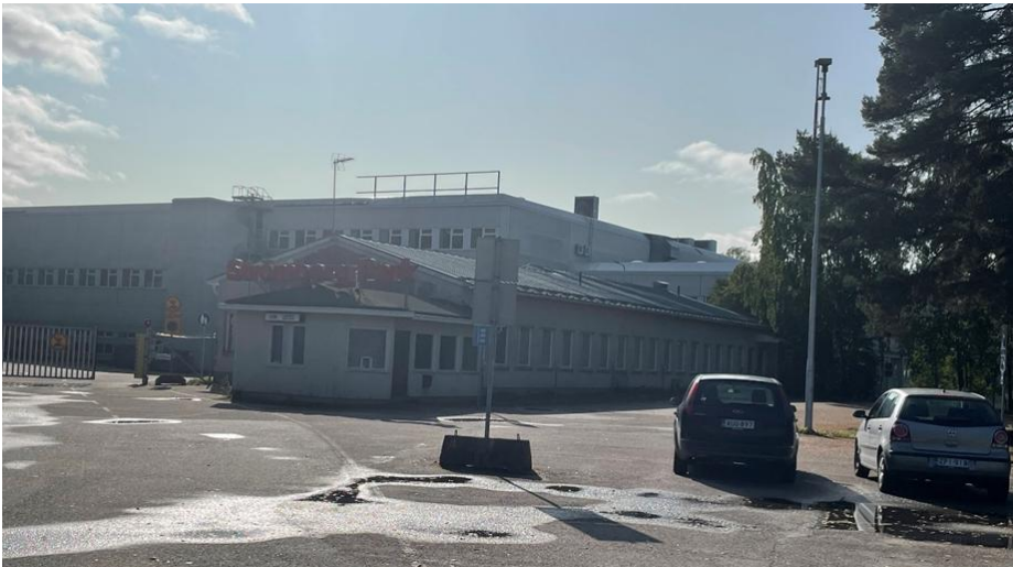
Pohjoisportti ja sosiaalirakennus sekä taustalla LP-rakennus.
