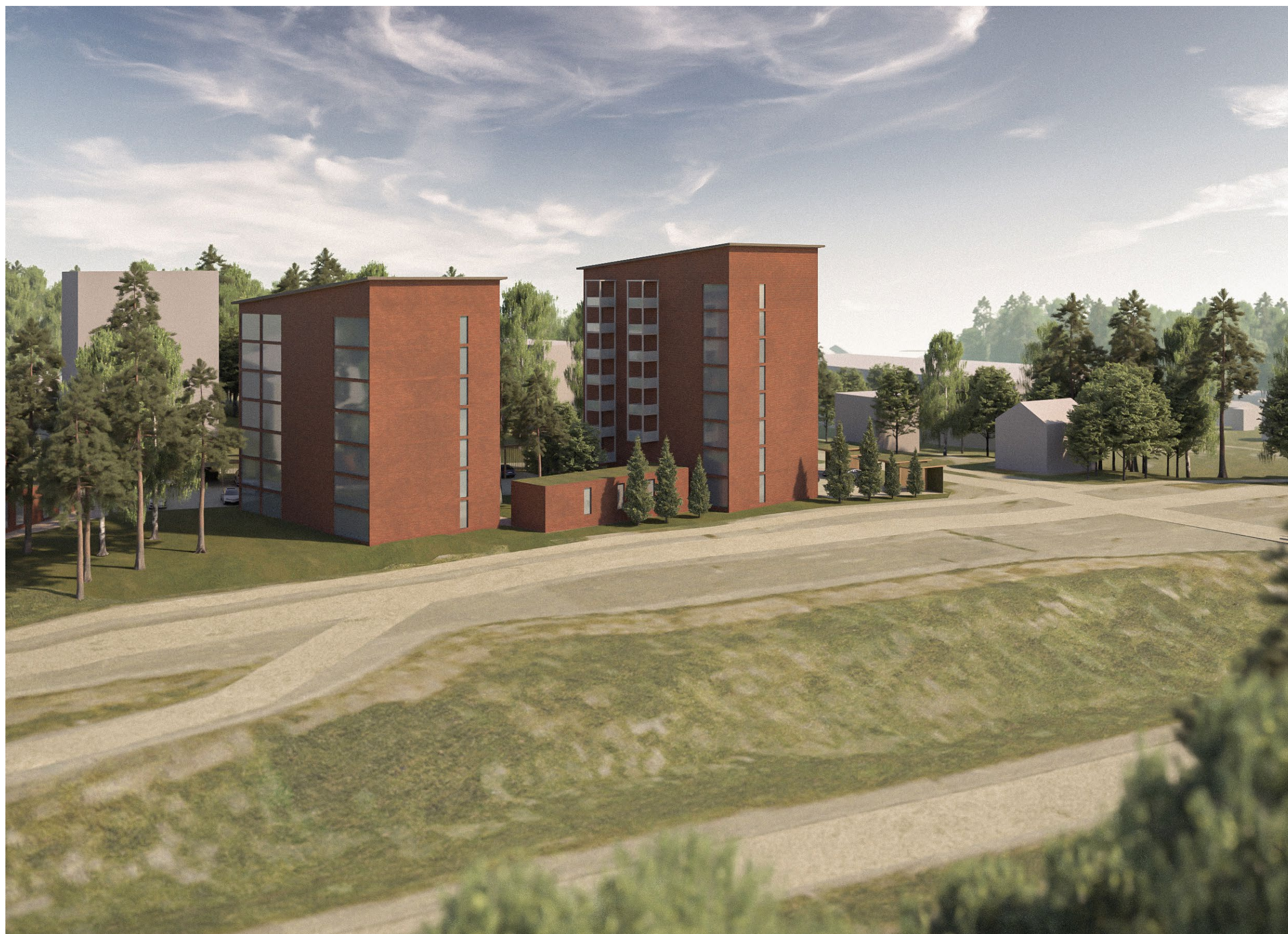
Karhuntie - kuvakulma 1 Börnvägen - bild 1
