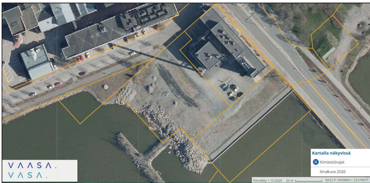
Bild 2. Flygbild och fastighetsgränserna i nuläget.
