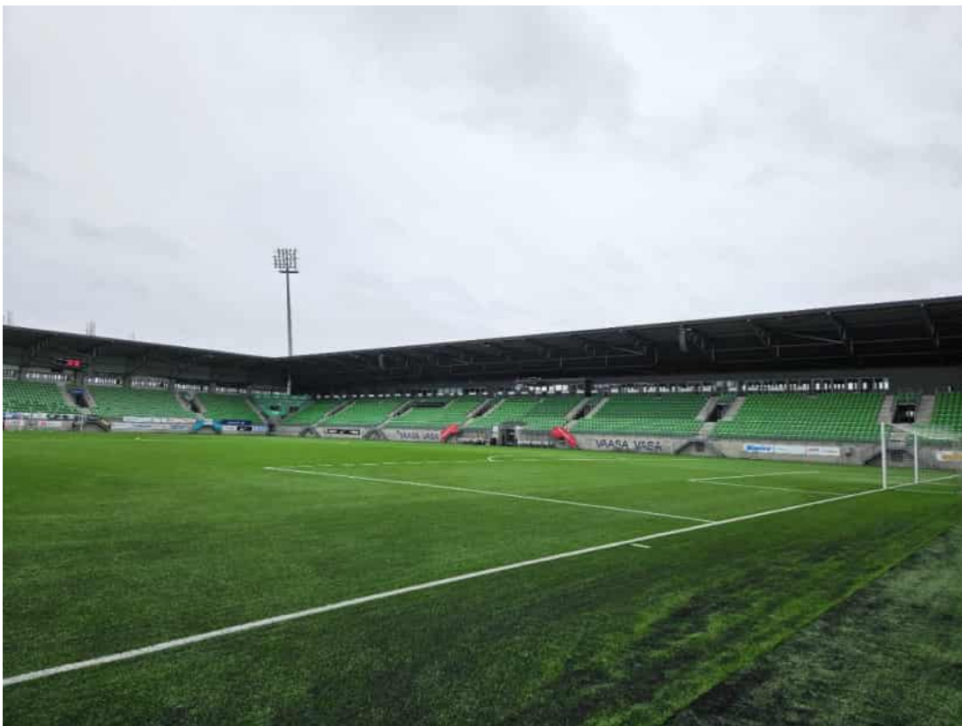
Kuva 29. Uuden katsomon pohjoisnurkka.
