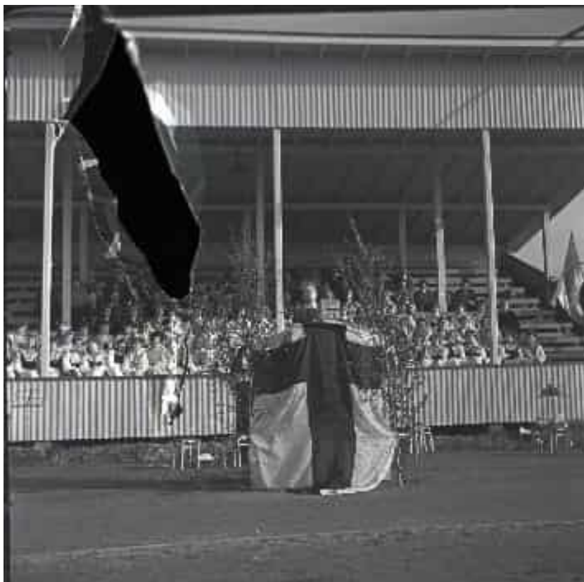
Kuva 53. Munsalan urheilukentän katsomo (Uusikaarlepyy) vuonna 1956. Rakennettu vuoden 1945 jälkeen. Katsomo on pieni ja katoksen rakenne erilainen kuin Hietalahdessa. Kuva: Karl Alfred Nyström, SLS. Arkistorakenne: ÖTA 139 foto 2926 "Munsala sommaren 1956". | Finna.fi
