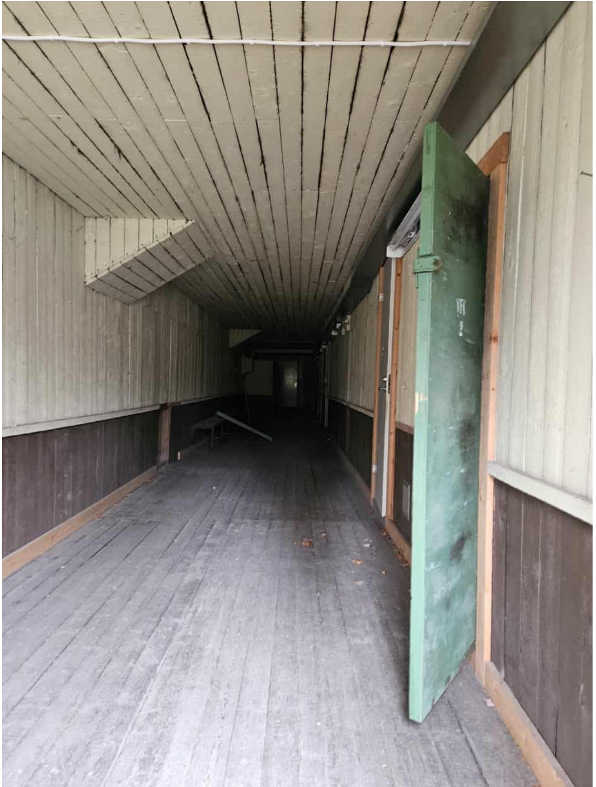
Kuva 41. Käytävä vanhan katsomon takana. Sisätiloihin ei ollut mahdollista tutustua tämän tarkemmin.
