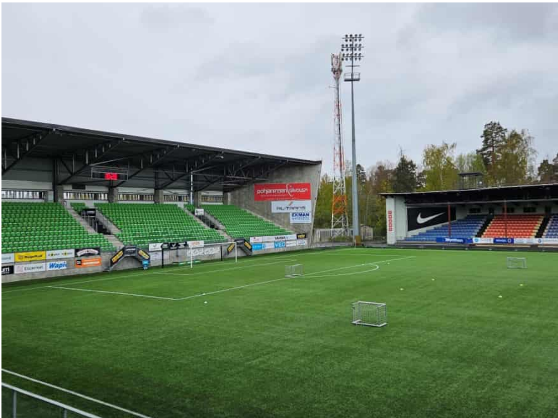
Kuva 31. Uusi katsomorakennus poikkeaa vanhasta sekä materiaaleiltaan että mittakaavaltaan.
