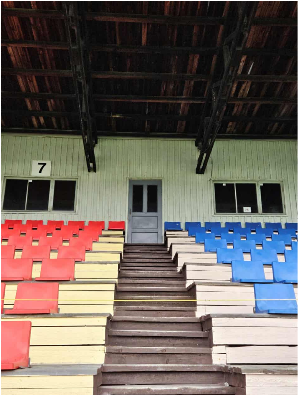
Kuva 42. Puukatsomo on säilyttänyt ominaispiirteensä hyvin, vaikka kirkkaan väriset muoviset istuimet ovatkin uudempaa tuotantoa.
