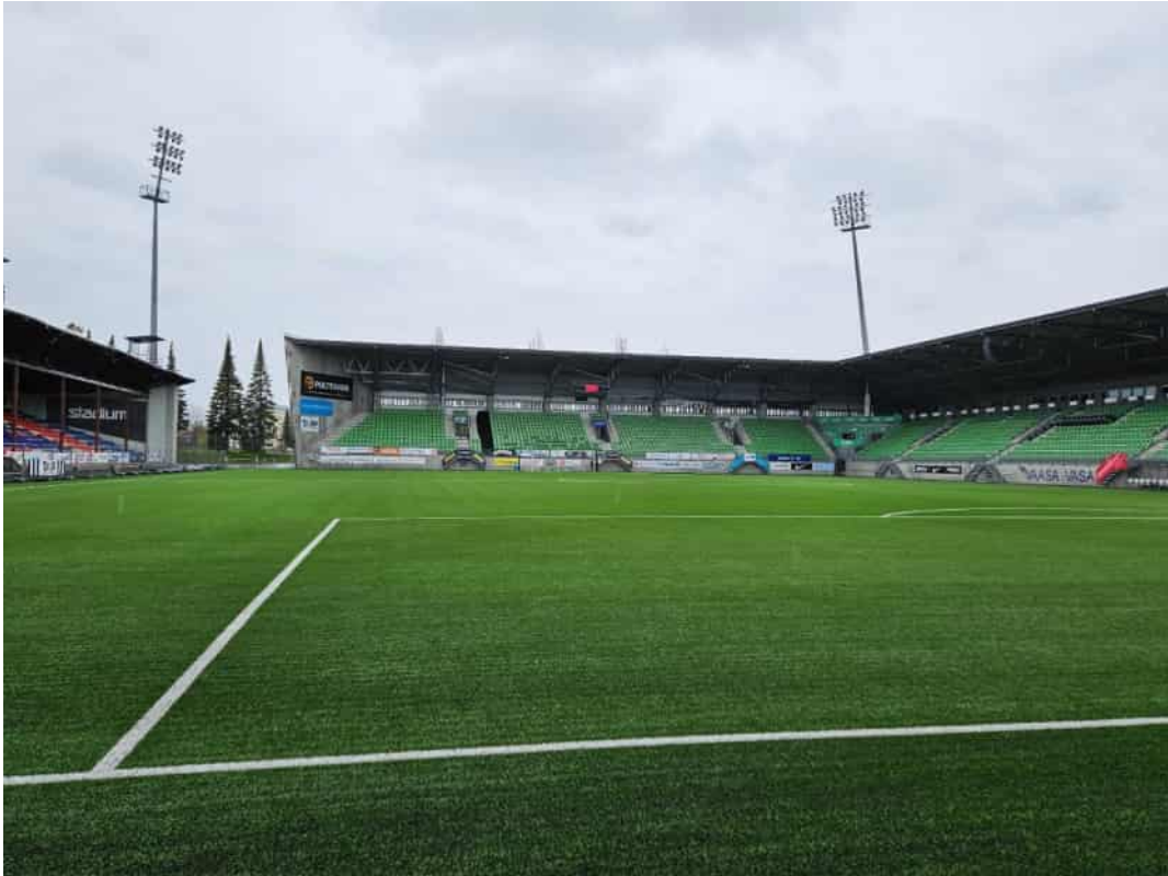
Kuva 28. Uuden katsomon pohjoispäätä. Vanha katsomo vasemmassa reunassa.
