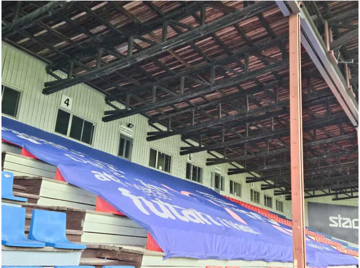
Kuva 45. Katosta kannattava puinen ristikkorakenne, jota on vahvistettu 2020-luvulla metallikoilla.
