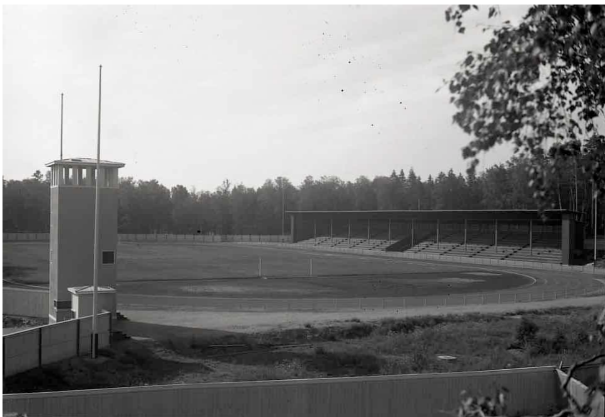
Kuva 6. Hietalahden aidattu kenttä, katettu katsomo ja maratontorni pian valmistumisensa jälkeen 1930-luvulla. Kuva: Pohjanmaan museo.
