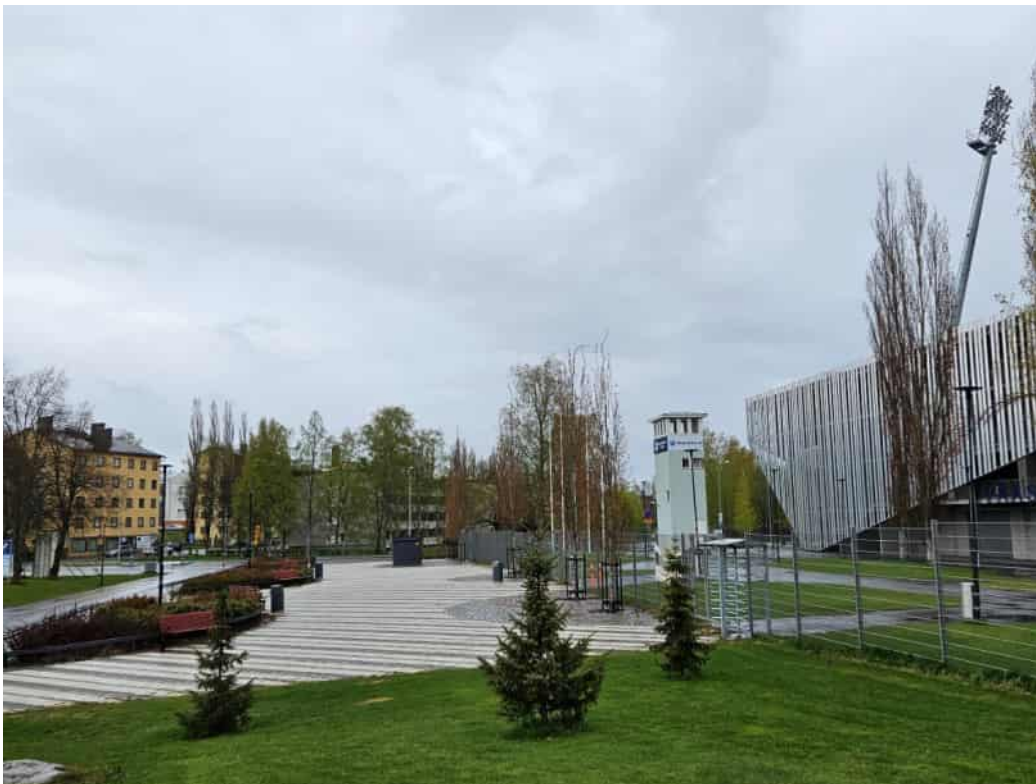
Kuva 21. Pohjoinen sisäänkäynti stadionille.
