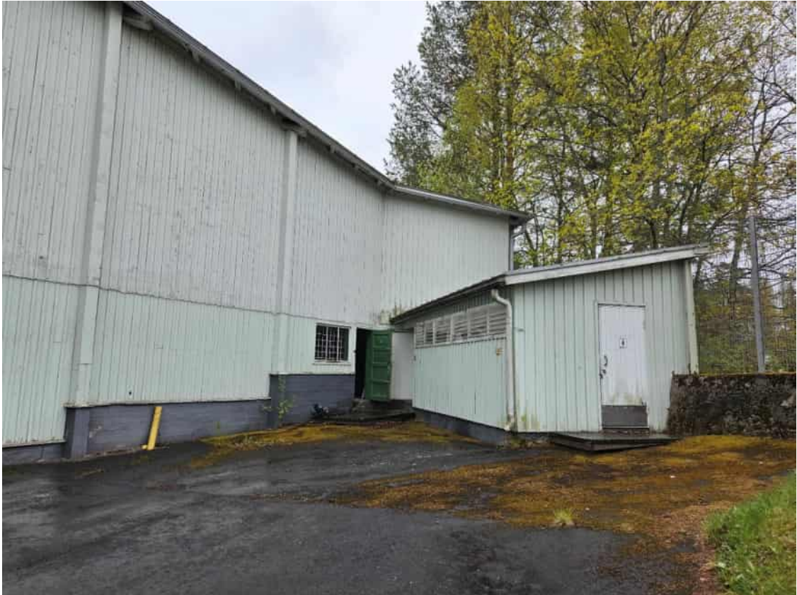
Kuva 39. Pohjoispäässä on 1960-luvulla rakennettu WC-siipi.
