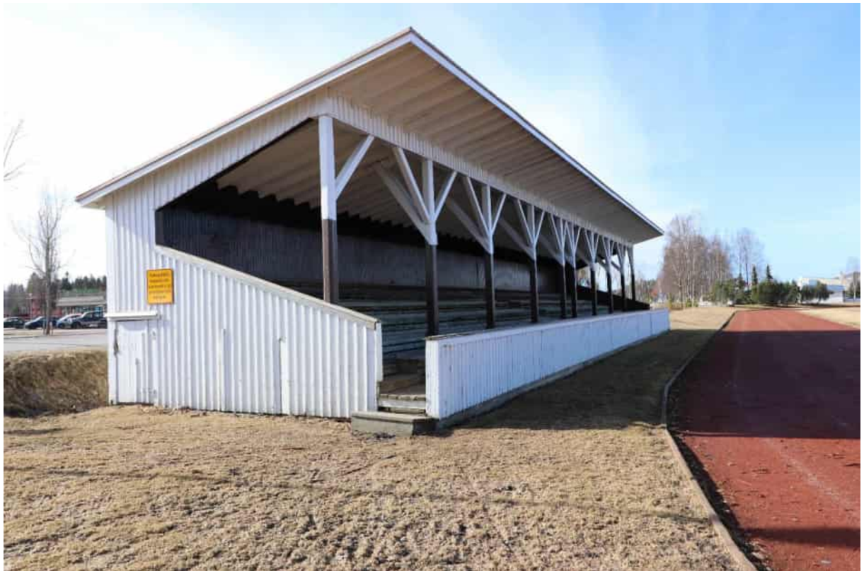
Kuva 52. Isonkyrön Keskusurheilukentän katsomo on rakennettu vuoden 1950 jälkeen. Kuva: Janne Holmgren 2017.
