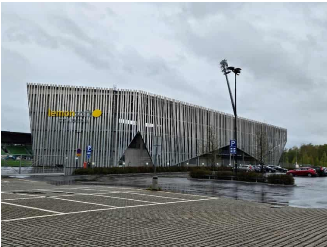
Kuva 23. Näkymä lounaasta pysäköintialueelta kohti stadionia. Uuden katsomon julkisivuissa on voimakas säleikköaihe, joka on mahdollisesti saanut innoituksen vanhan puukatsomon pystyrimaudoituksesta.
