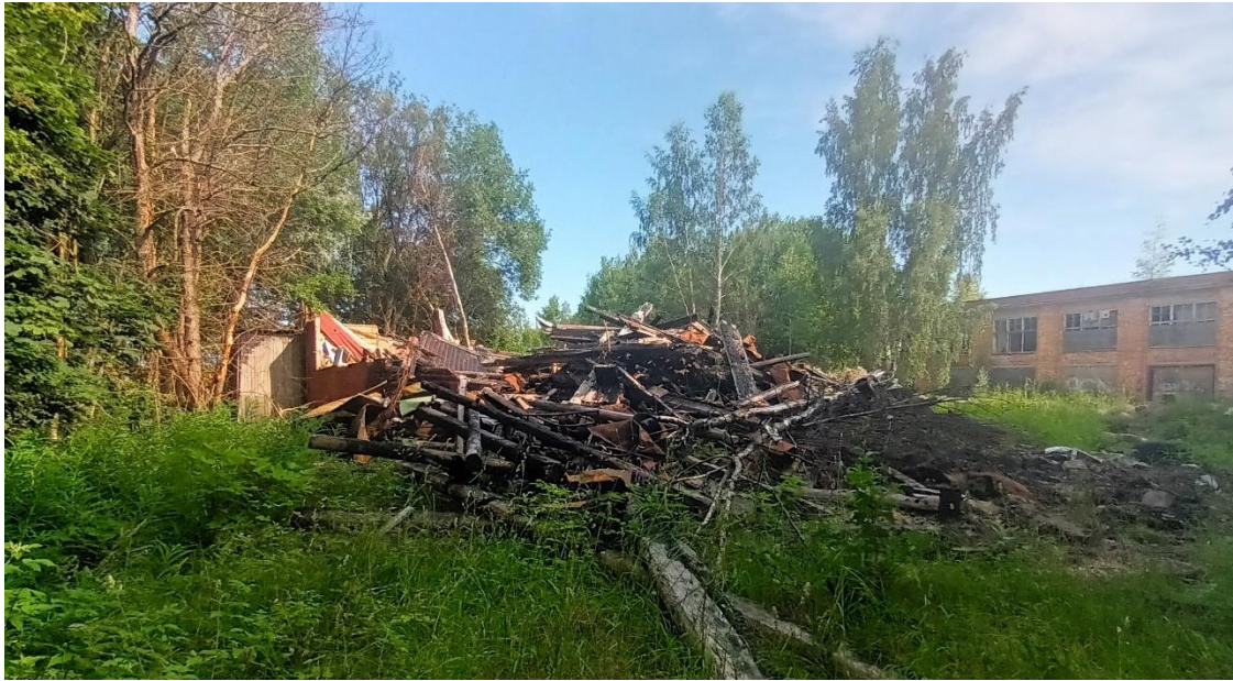
Kuva 44. Se mitä Luotsiaseman rakennuksesta (rakennus V) on jäljellä. Kuva, Oliver Schulte-Tigges, 23.7.2025
