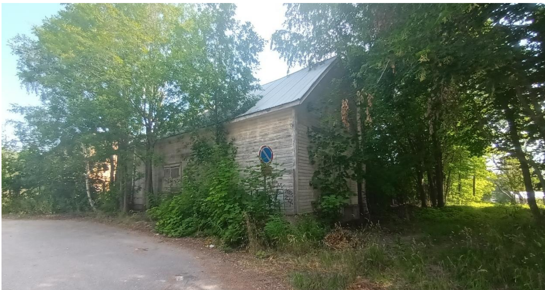
Kuva 36. Varastorakennus (rakennus III) Merenpuolelta. Kuva: Oliver Schulte-Tigges, 23.7.2025
