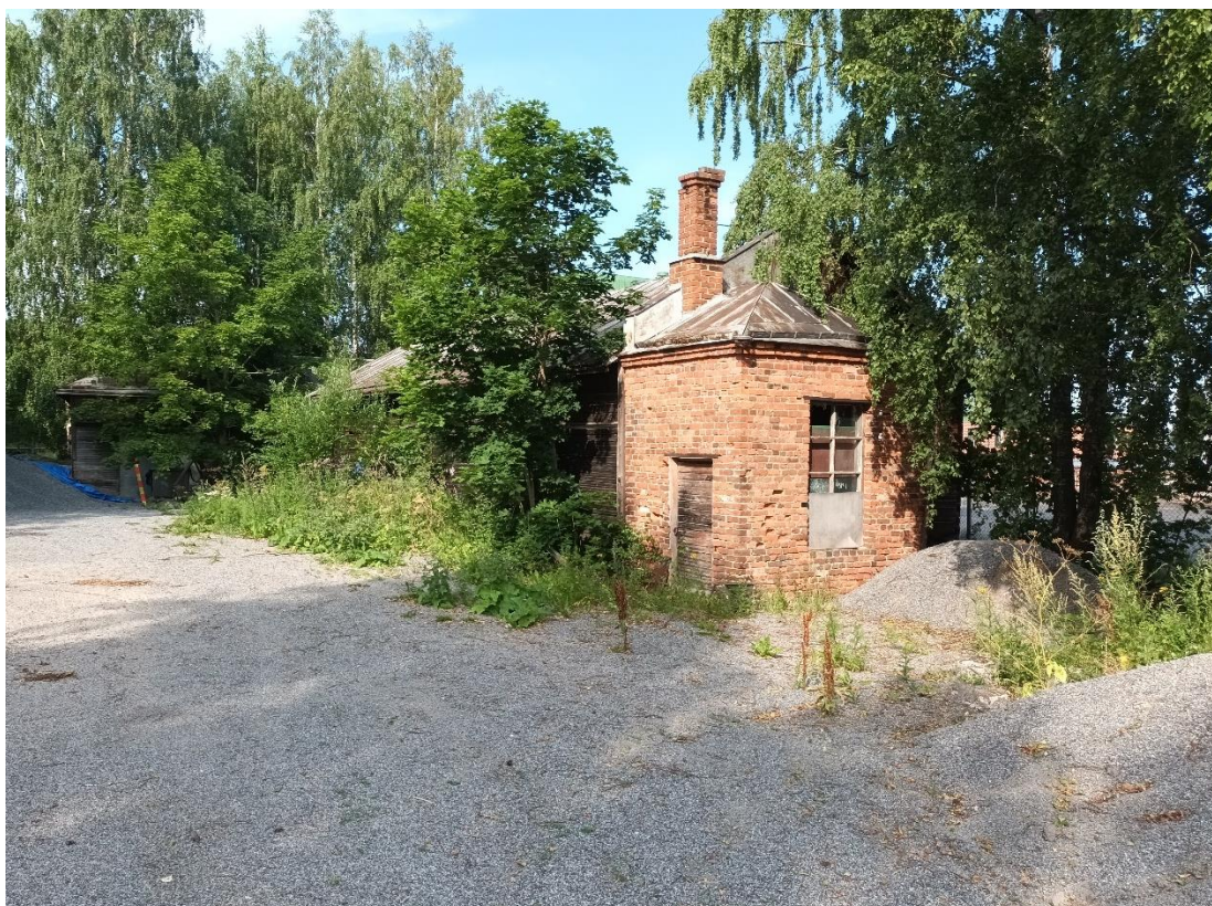
Kuva 51. Varastorakennus kaakosta (rakennus VII). Kuva, Oliver Schulte-Tigges, 23.7.2025
