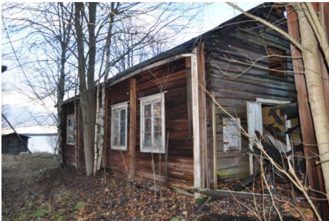
Kuva 58. Pajarakennus (rakennus II) marraskuussa 2015, Outi Orhanen.
