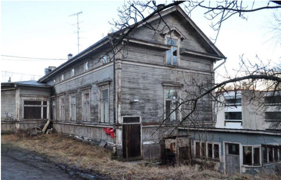
Kuva 31. Entinen konttori-asuinrakennus (rakennus II) ja portinvartijan rakennus (II A) sisäpihalta päin vuonna 2015. Kuva: Outi Orhanen.
