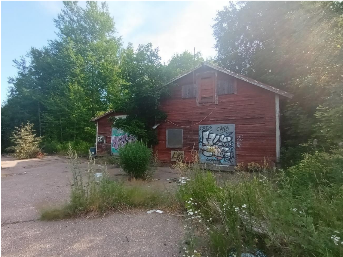
Kuva 57. Venevaja/varasto (rakennus I). Kuva, Oliver Schulte-Tigges, 23.7.2025.
