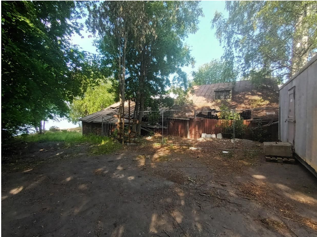
Kuva 13. venevaja/varastorakennus (rakennukset II ja III. Kuva: Oliver Schulte-Tigges , 23.7.2025
