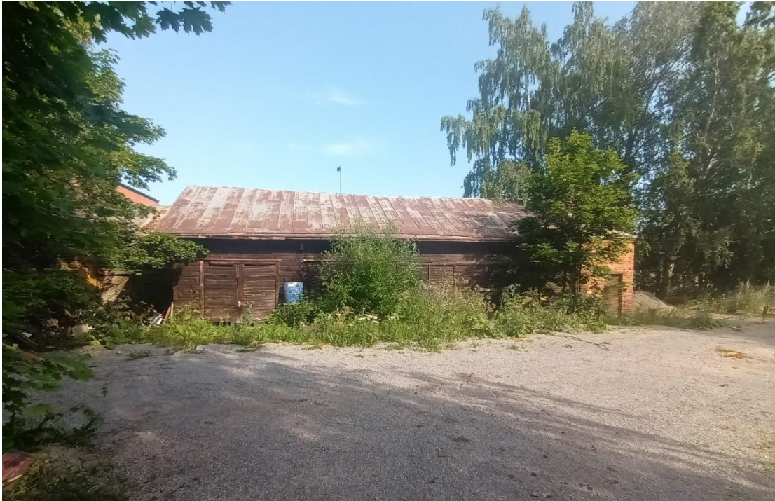
Kuva 52. Varastorakennus etelästä (rakennus VII). Kuva, Oliver Schulte-Tigges, 23.7.2025
