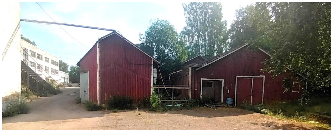
Kuva 11. Oikealla venevaja/varastorakennus (rakennukset II ja III), vasemmanpuoleinen rakennus on osa IV, joka liittyy kivirakenteiseen tehdasrakennukseen. Kuva: Oliver Schulte-Tigges , 23.7.2025
