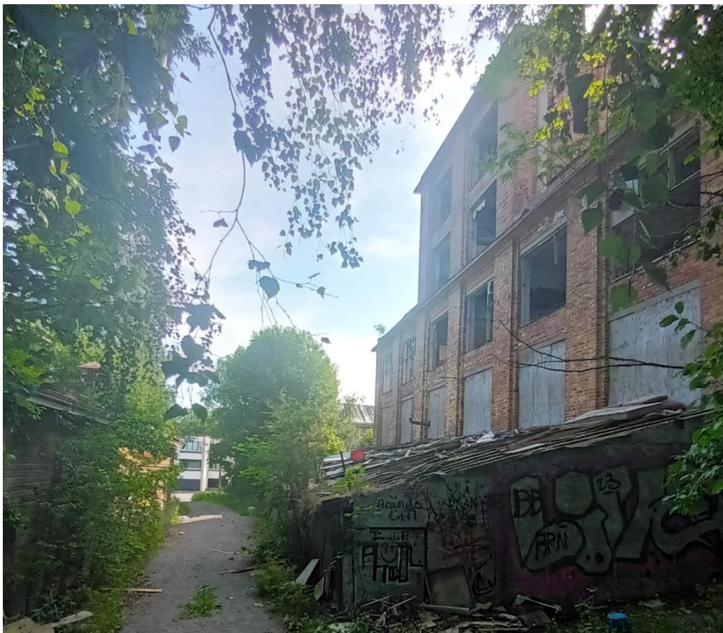
Kuva 30. Vanha saippuan tehdasrakennuksen pohjoispääty (rakennus I) oikealla ja makasiinirakennus (rakennus VI) vasemmalla. Kuva: Oliver Schulte-Tigges, 23.7.2025
