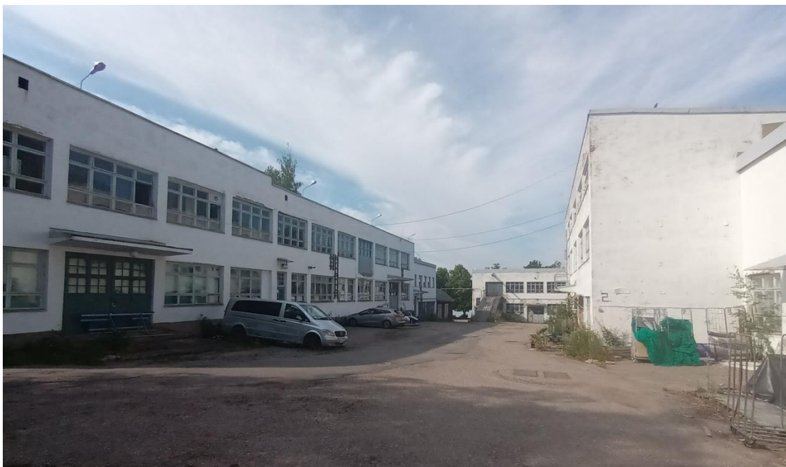
Kuva 15. Uudempi tehdasrakennus pohjoisen puoleiselta sisäpihalta vasemmalla (rakennukset V ja VI). Kuva: Oliver Schulte-Tigges, 23.7.2025
