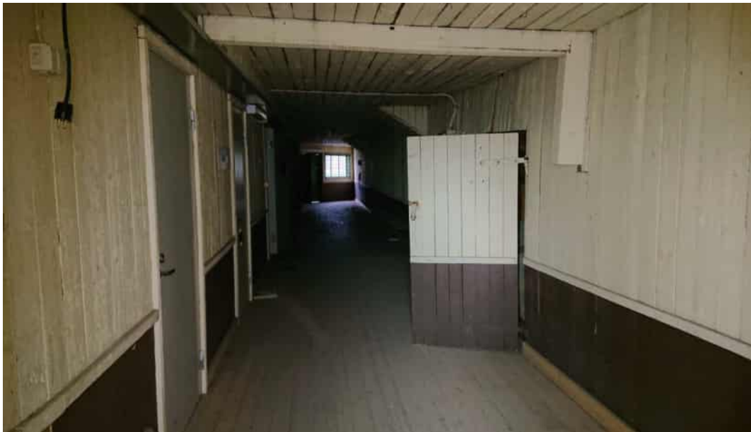
Kuva 21. Yleiskuva alimman kerroksen käytävältä.
