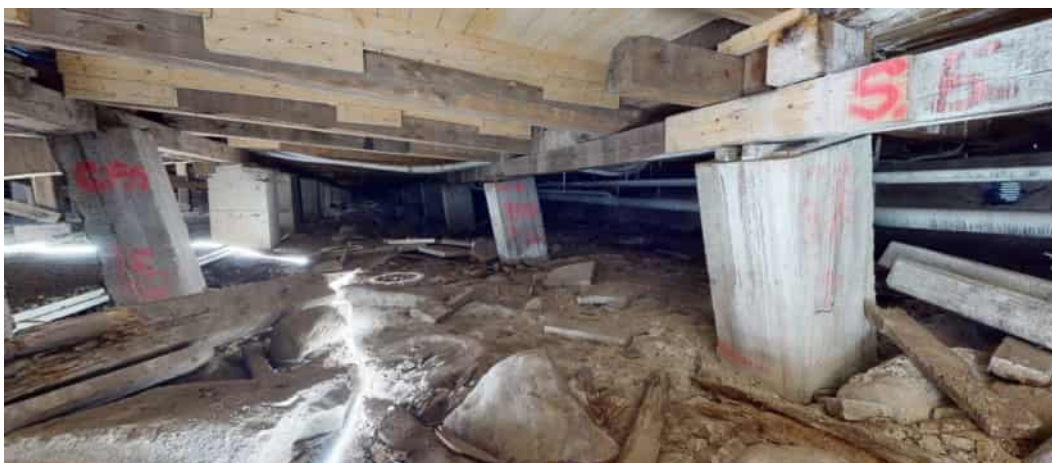
Kuva 16. Perustukset. Kentän puoli vasemmalla, oikealla puolella näkyvät perustukset tukevat katosta katsomon takaseinälinjalla.
