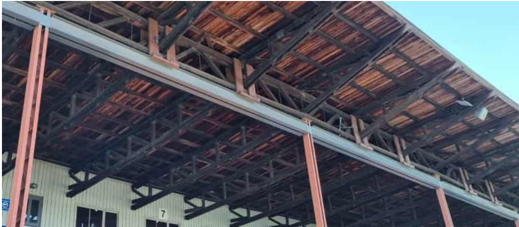
Kuva 5. Yleiskuva vanhan pääristikon vuonna 2016 korvanneista uusista teräspalkeista ja sekundääriristikoiden tuennoista. (Valokuva Ramboll Finland Oy)
