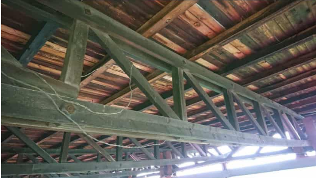
Kuva 7. Sekundääriristikko.
