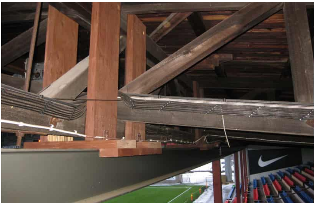
Kuva 6. Vuonna 2016 toteutettu sekundääriristikoiden tuenta, joka siirtää kuorman pois pääristikoilta uusille teräspalkeille.
