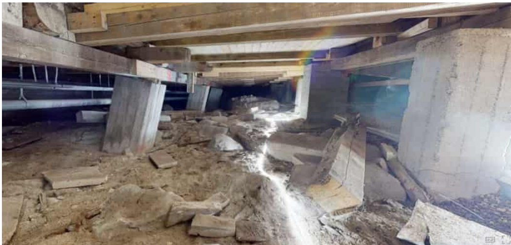
Kuva 14. Perustukset. Kentän puoli oikealla, vasemmalla puolella näkyvät perustukset tukevat katosta katsomon takaseinälinjalla.
