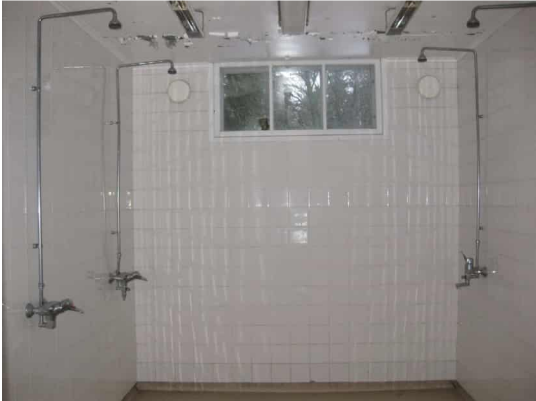
Kuva 20. Yleiskuva alimman kerroksen suihkutilasta.
