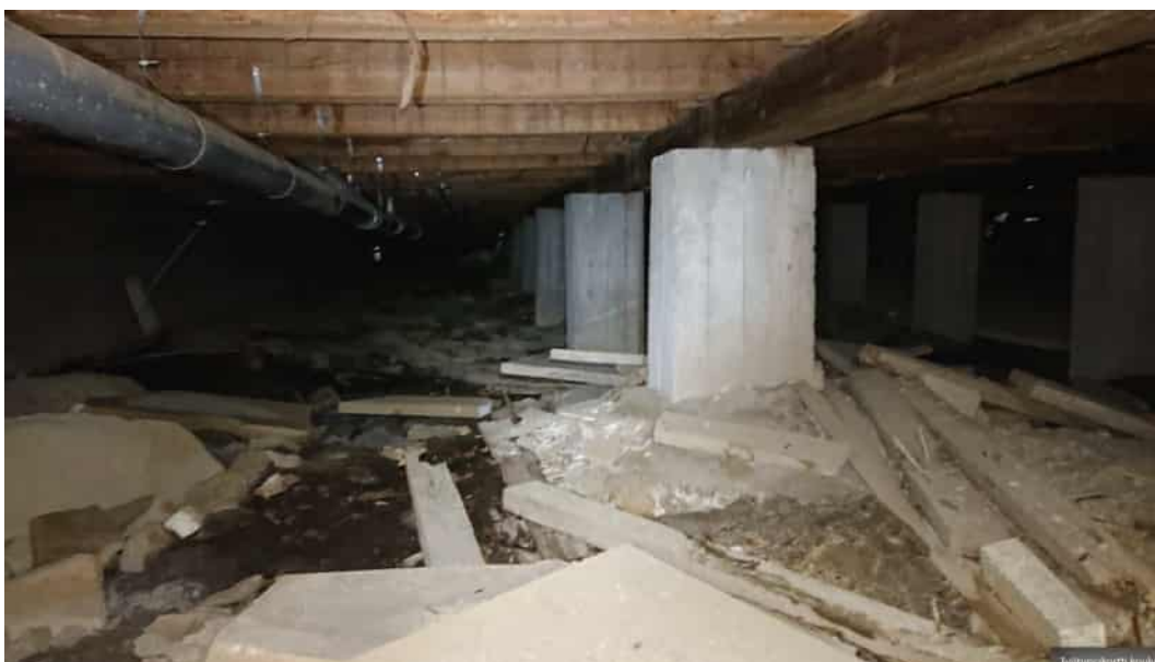
Kuva 25. Ryömintätilan yleiskuva varastojen alapuolella.
