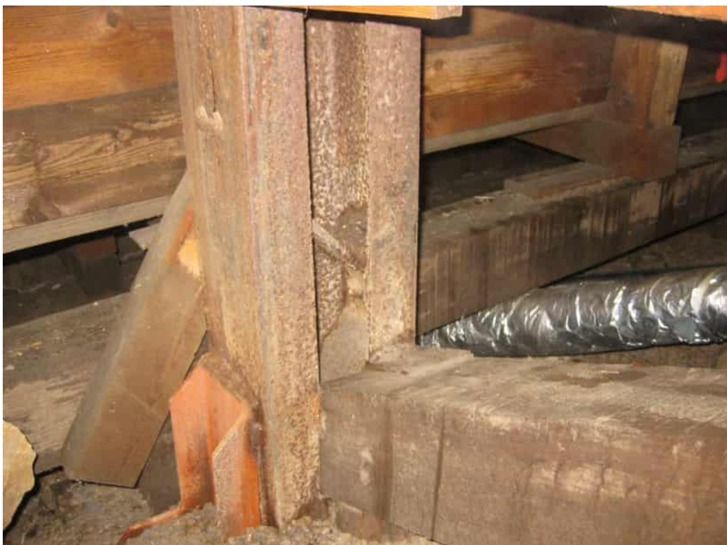
Kuva 18. Katoksen kentän puoleisen teräspilarin alapää.
