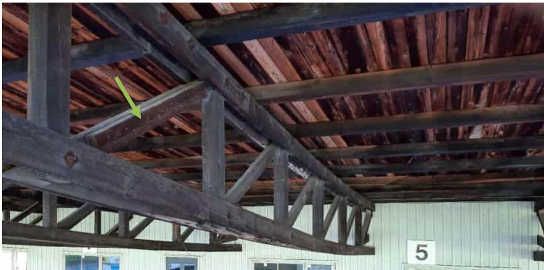
Kuva 8. Sekundääriristikko jossa näkyy diagonaalin vahvistus. Risikoiden taipuma on silmämääräisesti selvästi havaittavissa. (Valokuva Ramboll Finland Oy)
