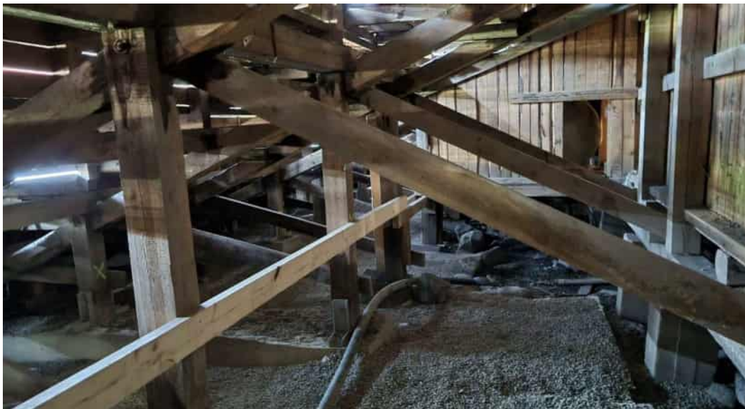
Kuva 24. Katsomon istuinosien alapuoliset kantavat puurakenteet.
