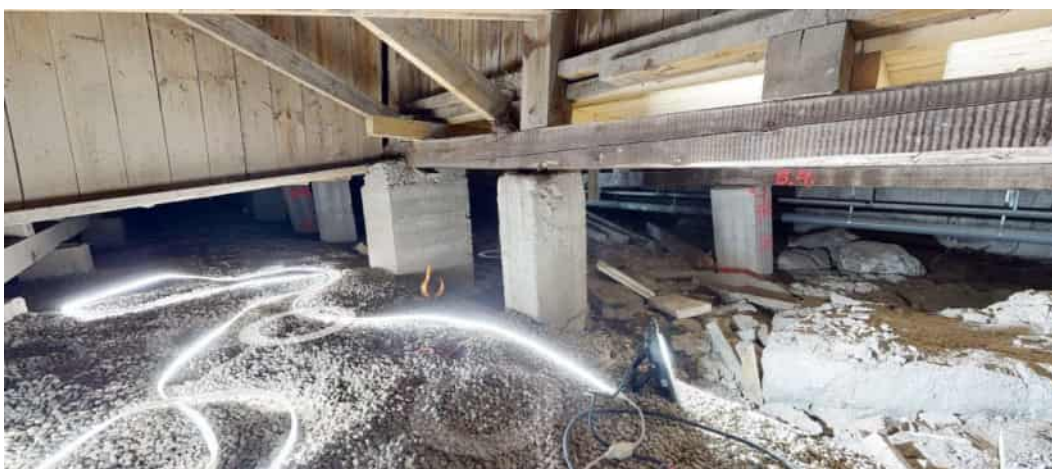
Kuva 15. Perustukset. Kentän puoli vasemmalla, oikealla puolella näkyvät perustukset tukevat katosta katsomon takaseinälinjalla.
