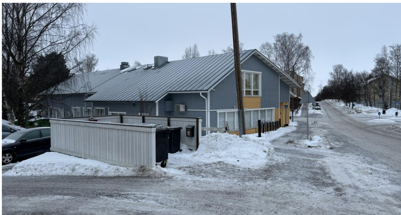
Bild: Arbetarföreningshuset sett från Kråkfjärdsgatan.
