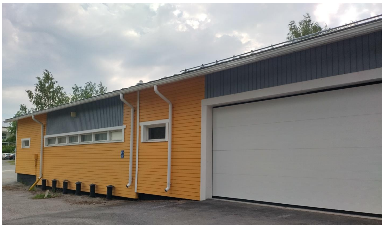
Kuva 43 Rakennuksen luoteispuoli Pikitehtaankadun suuntaan, kuva vuodelta 2021
