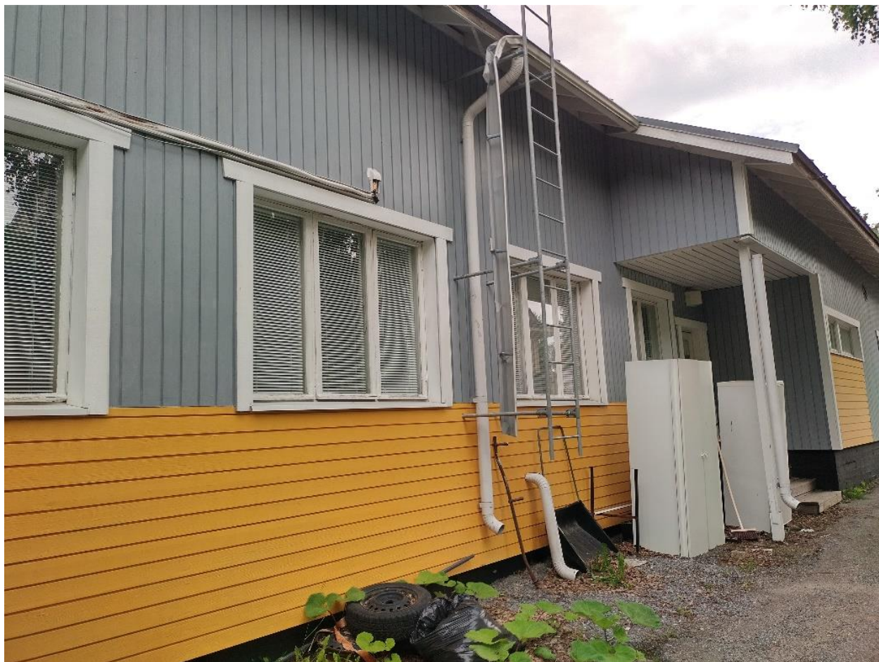
Kuva 40 Rakennuksen kaakkoisseinusta, kuva vuodelta 2021
