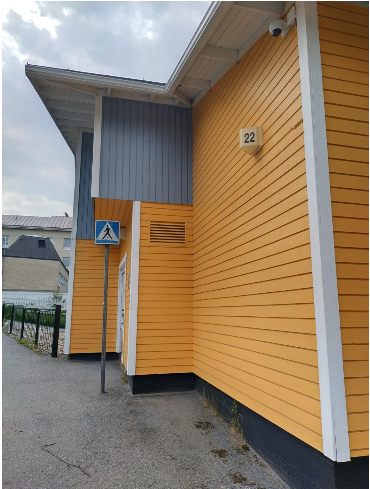
Kuva 44 Rakennuksen koillinen julkisivu kuvattuna luoteesta, kuva vuodelta 2021
