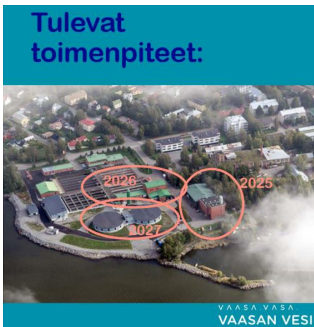
Kuva 24. Pättin puhdistamolla vuosina 2025-2027 tehtävien hajua vähentävien toimenpiteiden kohteet.
