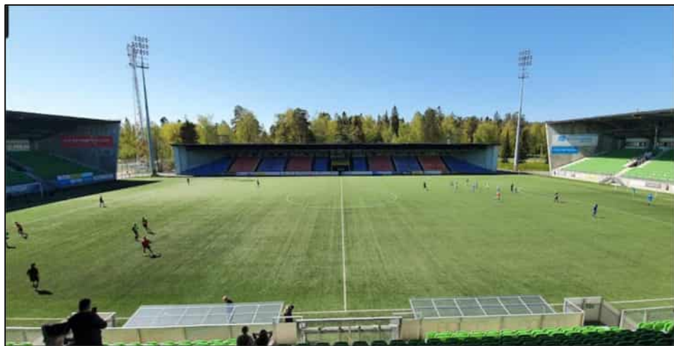
Fotbollsstadion. Träläktaren bak i mitten på bilden.
