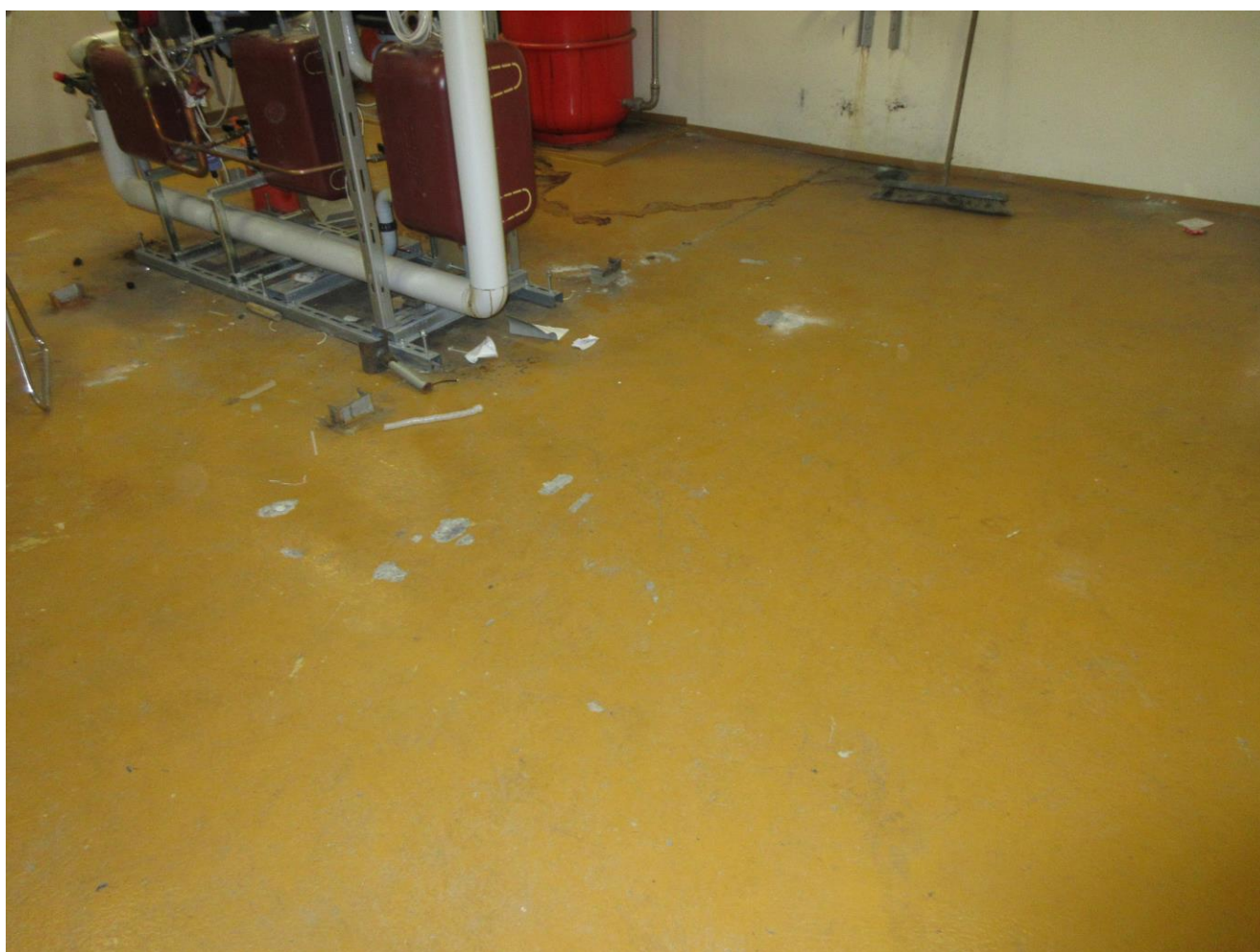
Kuva 21 5.9.2022 Lämmönjakuhuone/portaat: Näyte 13 otettiin lattiamaalista ja tasoitteesta, näyte sisältää vain pieniä määriä PCB ja lyijyä. Jäteluokitus on tavanomainen jäte.
