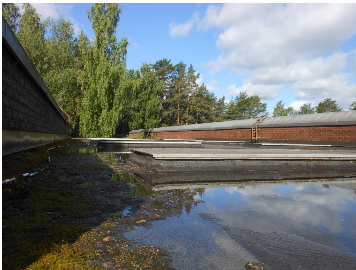
Kuva 2 8.7.2022 Katos: Näyte 2 otettiin kattohuovasta ja kiinnitysbitumista, näyte ei sisällä asbestia ja PAH pitoisuus on <5,68 mg/kg
