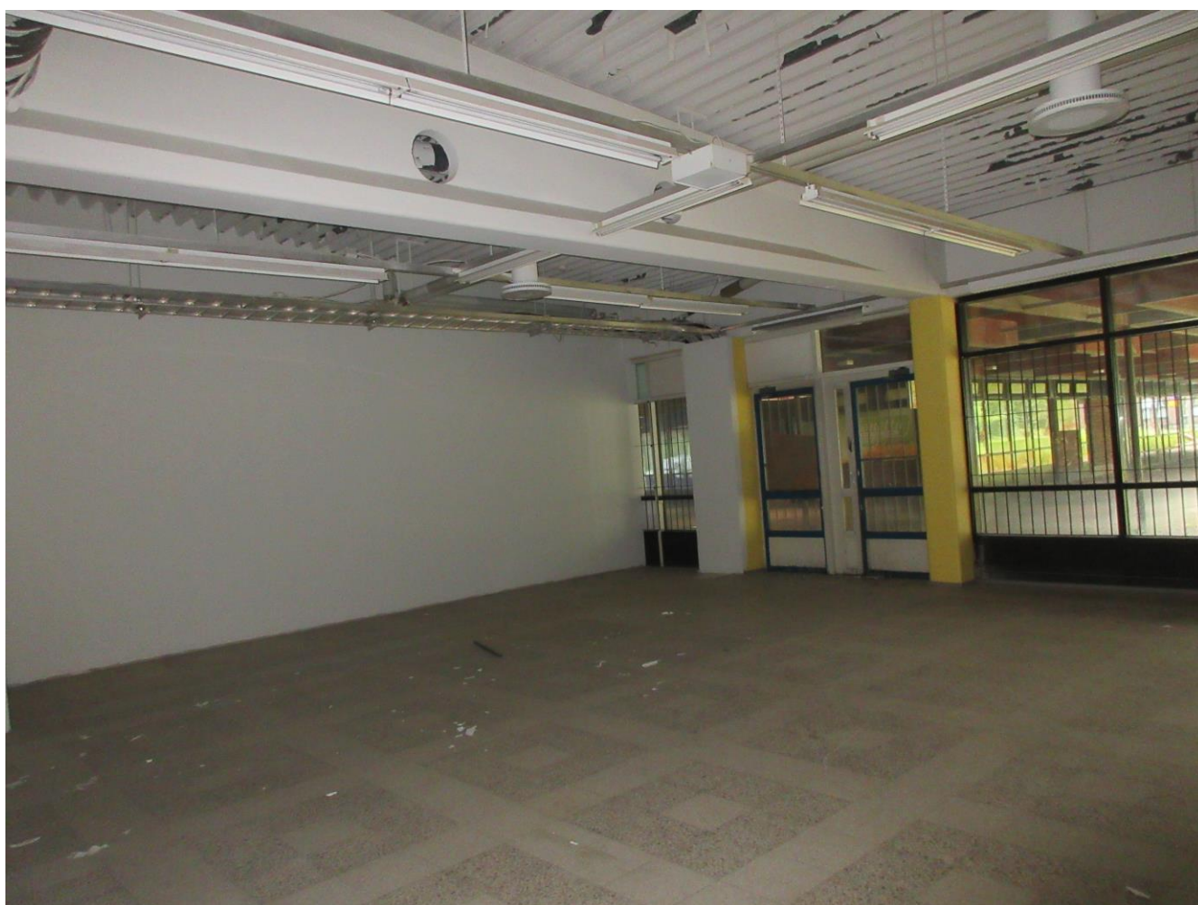
Kuva 18 5.9.2022 Ent.myymäla: Näyte 10 otettiin ilmastointikanavien/katon maalista,näyte sisältää Lyijyä yli rajaarvon.Jätteet luokitellaan vaaralliseksi jätteeksi.
