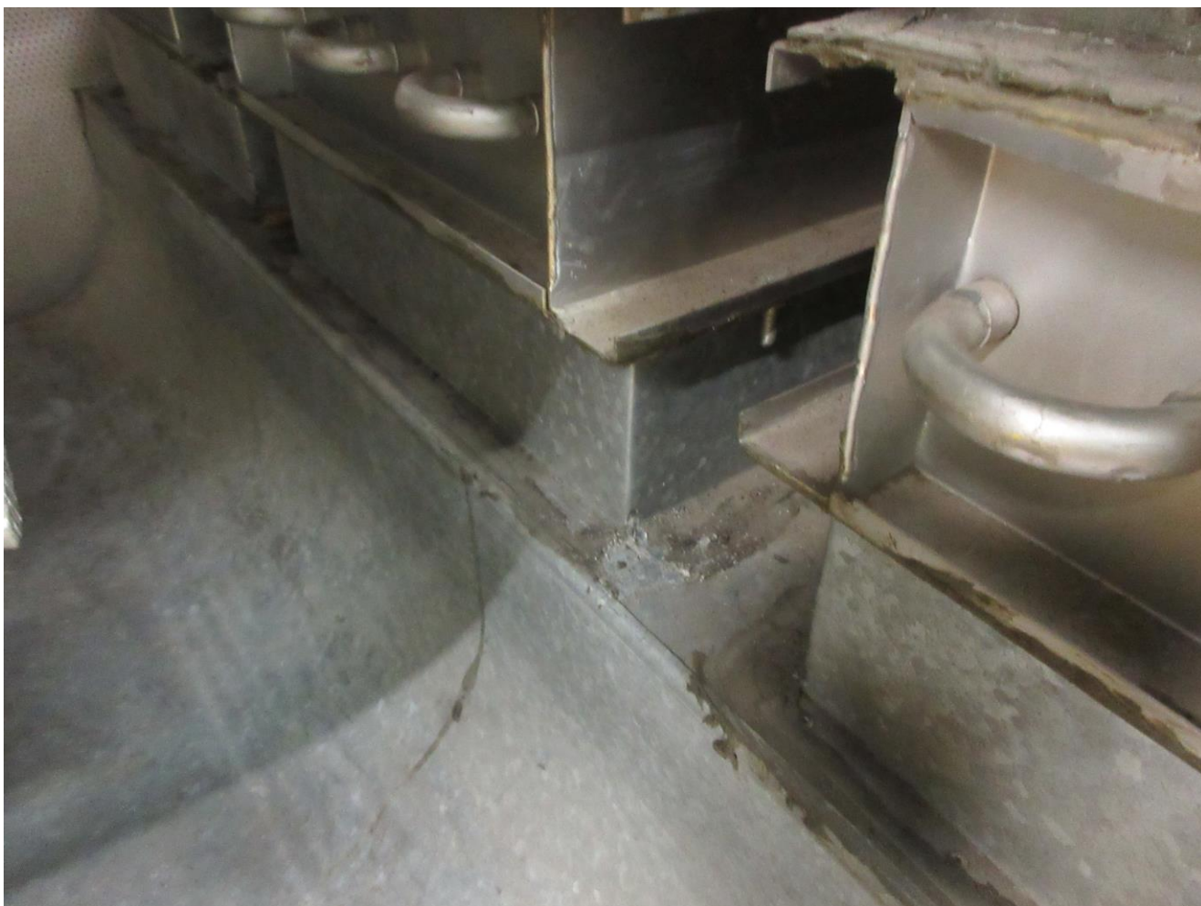
Kuva 22 5.9.2022 IV konehuone: Näyte 14 otettiin iv kanavien tiivistyskitistä,näyte ei sisällä asbestia
