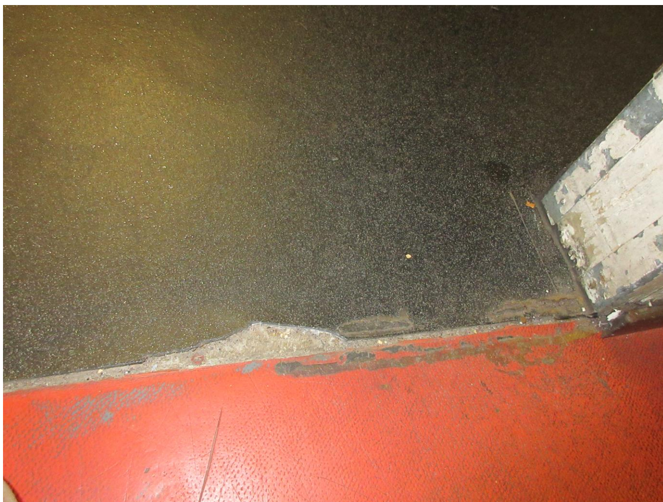
Kuva 11 5.9.2022 Keittiö ent.ravintola Messi: Näyte 3 otettiin lattiamatosta,liimasta ja tasoitteesta, näyte ei sisällä asbestia
