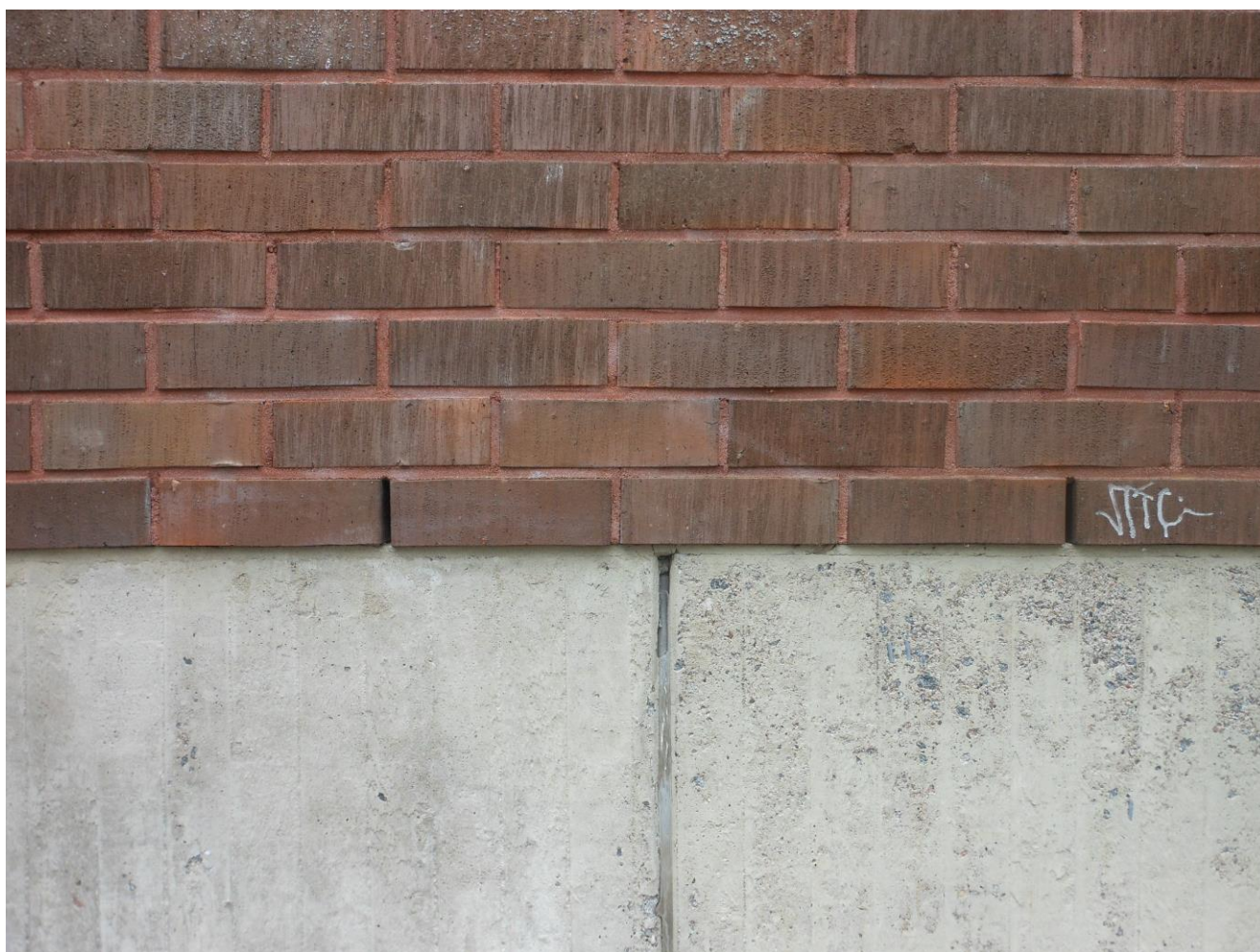
Kuva 3 8.7.2022 Julkisivut myymäläosa:Näyte 3 otettiin elementtisaumojen tiivistyskitistä, näyte sisältää PCB <6,12 mg/kg mutta lyijyä yli rajarvon 14600 mg/kg Tiivistyskiti luokitellaan vaaralliseksi jätteeksi.
