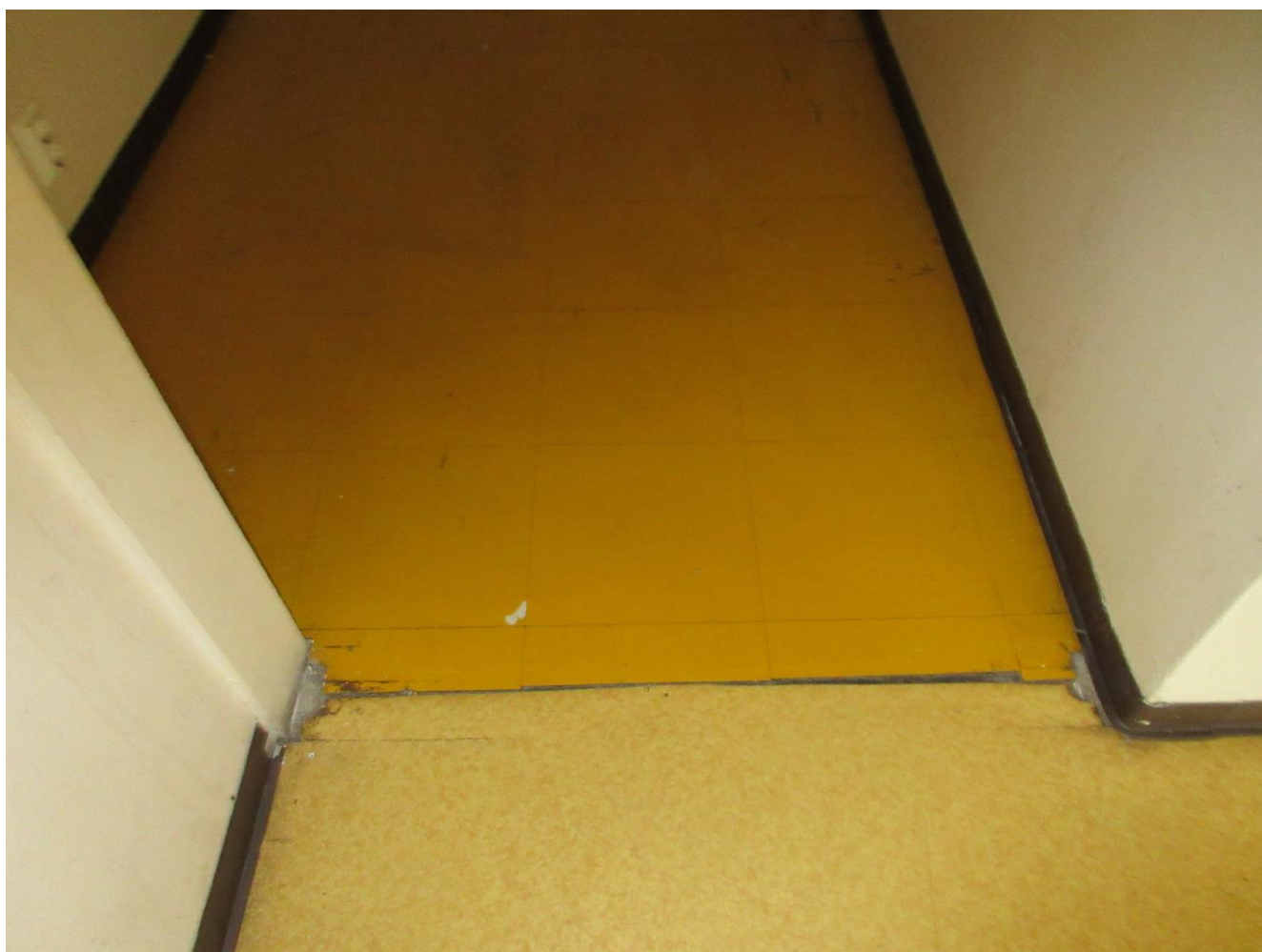
Kuva 16 5.9.20222 Varasto ent.postitoimisto: Näyte 8 otettiin lattian vinyylilaatasta ja liimasta, näyte ei sisällä asbestia
