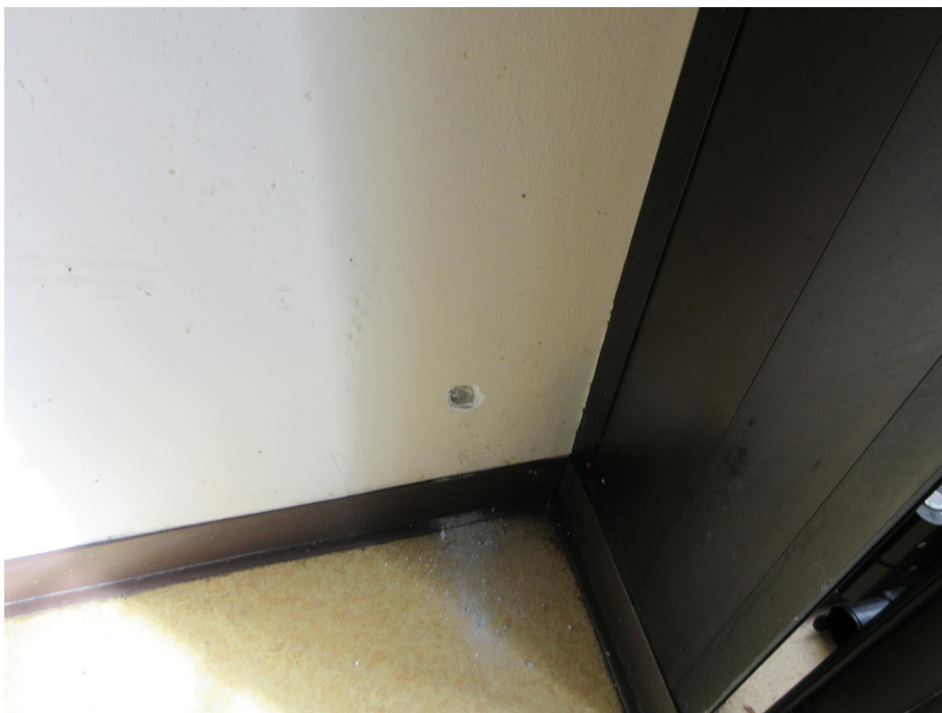
Kuva 14 Eteinen ent.postitoimisto: Näyte 6 otettiin seinämaalista ja tasoitteesta,näyte ei sisällä asbestia
