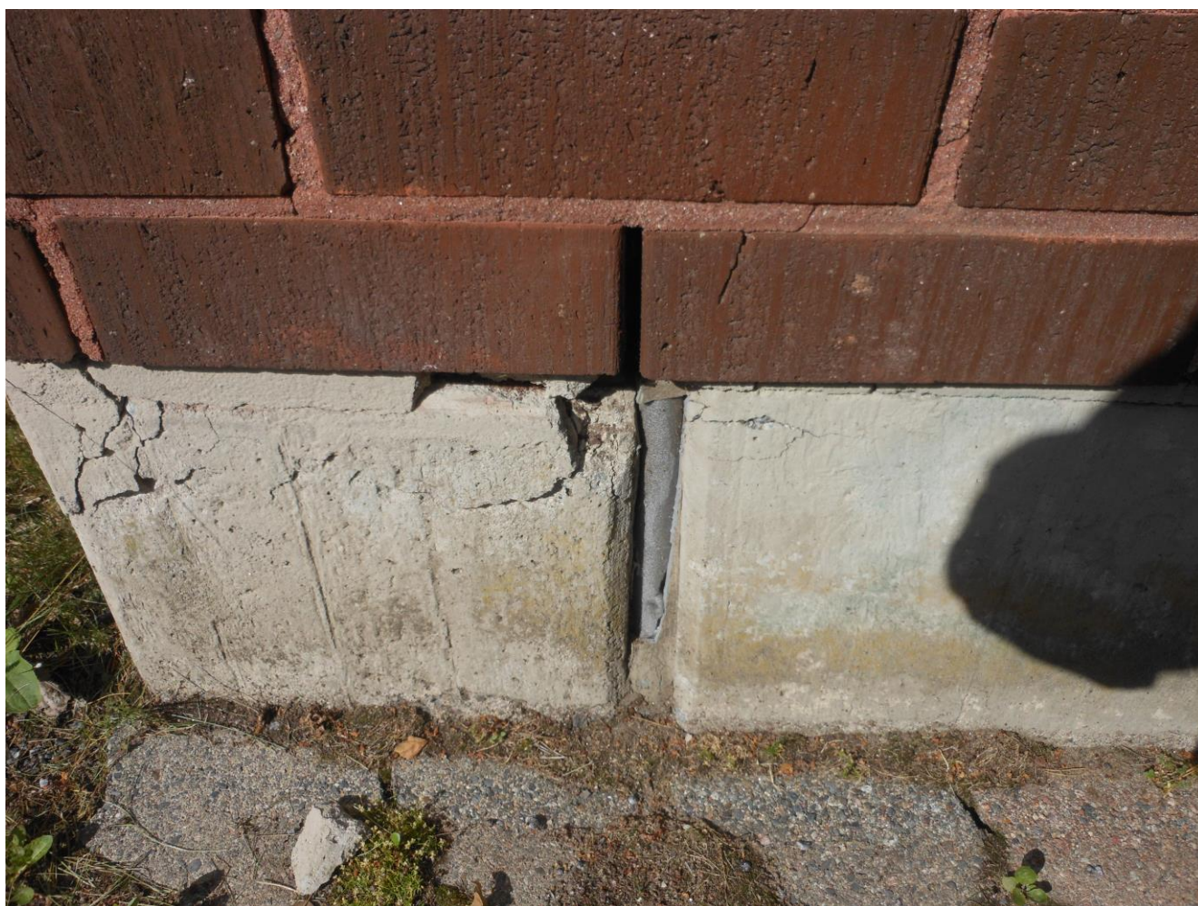
Kuva 4 8.7.2022 Seurakuntaosa: Näyte 4 otettiin sokkelin saumakitistä, näyte sisältää PCB <6,12mg/kg mutta lyijypitoisuus on 17300 mg/kg. Tiivistyskitti luokitellaan vaaralliseksi jätteeksi
