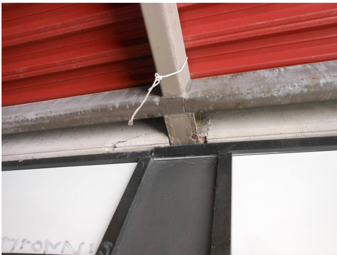
Kuva 5 8.7.2022 Katos: Näyte 5 otettiin metallipalkkien maalista, näyte sisältää raskasmetalleja yli rajarvojen ja jätteet luokitellaan vaaralliseksi jätteeksi
