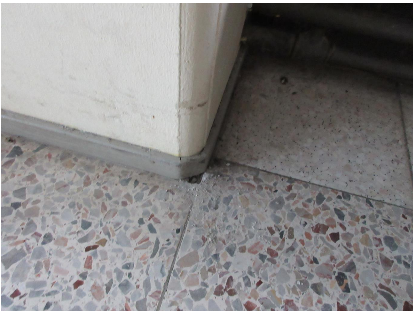
Kuva 20 5.9.2022 Ent.myymä: Näyte 12 otettiin lattian mosaiikkilaatan sauma ja kiinnityslaasteista, näyte ei sisällä asbestia
