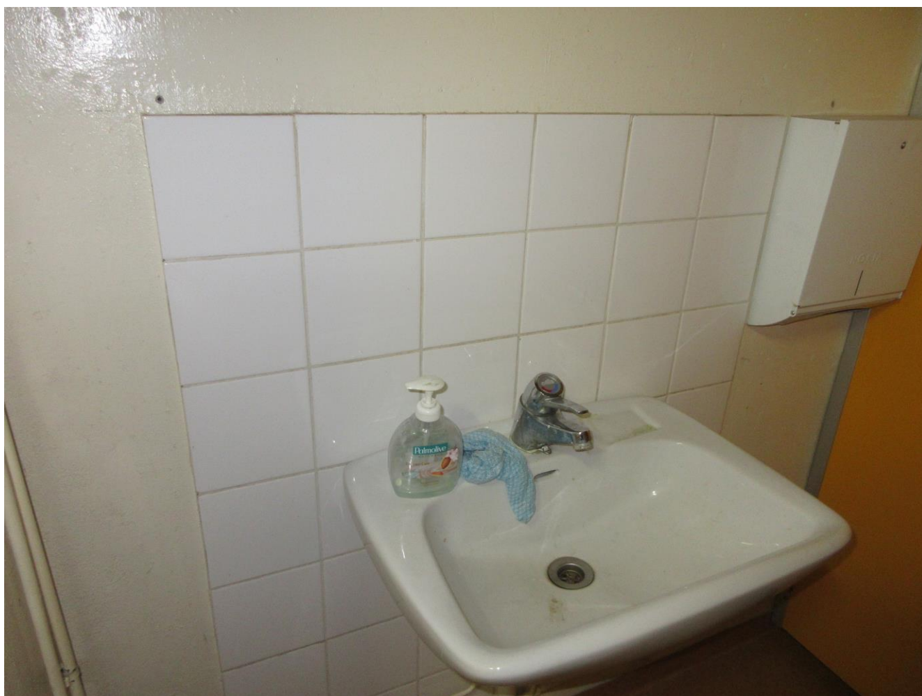
Kuva 23 15.9.2022 Wc kellari: Näyte 15 otettiin valkoisen kaakelin sauma ja kiinnitys laasteista, näytteen saumalaasti sisältää asbestia
