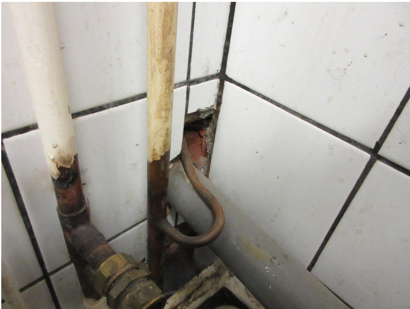
Kuva 12 5.9.2022 Keittiö ent.ravintola Messi: Näyte 4 otettiin seinäkaakelin sauma ja kiinnitys laasteista,näytteen saumalaasti sisältää asbestia
