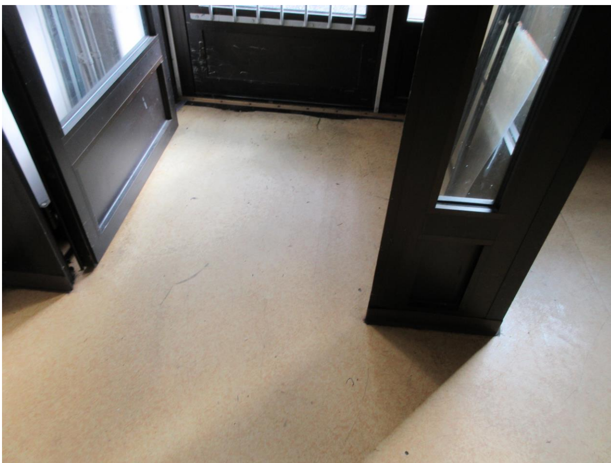
Kuva 17 5.9.2022 Tuulikaappi ent.postitoimisto: Näyte 9 otettiin lattiamatosta,liimasta ja tasoitteesta,näyte ei sisällä asbestia
