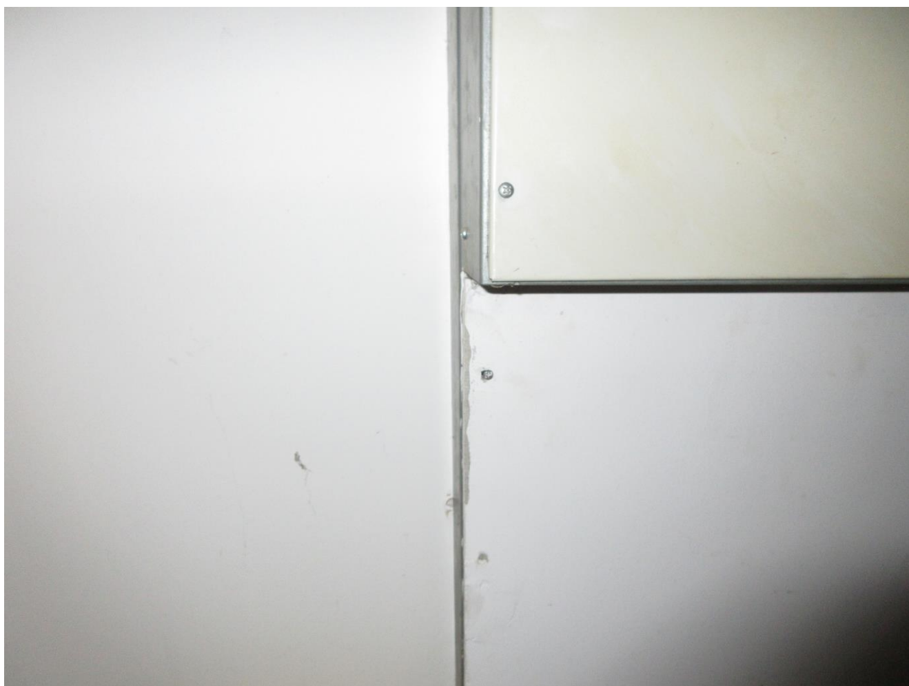
Kuva 9 5.9.2022 Sähkökeskus ent.ravintola Messi: Näyte 1 otettiin Luja seinälevystä ,näyte sisältää asbestia
