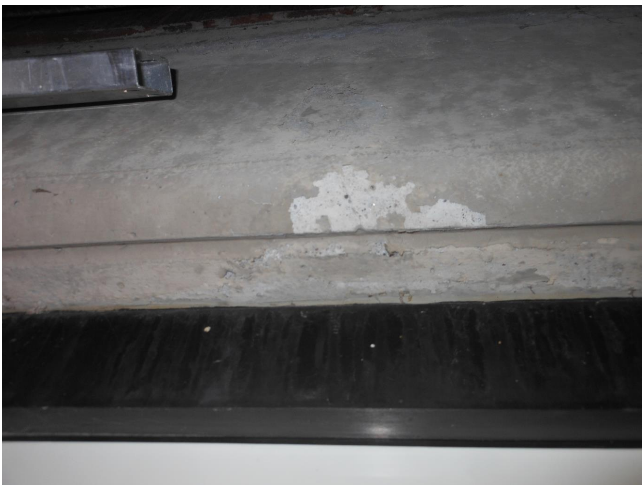
Kuva 6 8.7.2022 Katos,sokkelit: Näyte 6 otettiin betonipalkkien ja sokkelin maalista,näyte ei sisällä raskasmetalleja ja jätteet luokitellaan tavanomaiseksi jätteeksi
