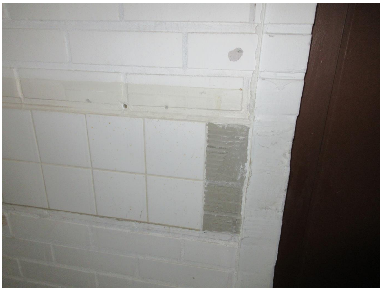
Kuva 19 5.9.2022 Ent.myymäla:Näyte 11 otettiin seinäkaakelin sauma ja kiinnityslaasteista,näytteen saumalaasti sisältää asbestia
