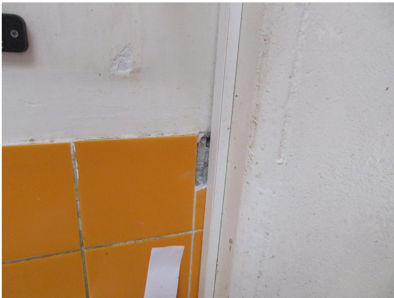
Kuva 13 5.9.2022 Keittiö ent.postitoimisto: Näyte 5 otettiin seinäkaakelin sauma ja kiinnityslaasteista näyte ei sisällä asbestia
