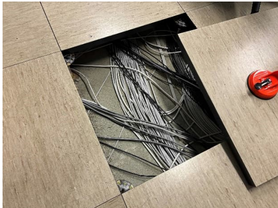
Kuva 13. Studiosiiven asennuslattian aukaisu.
