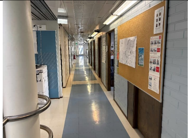
Kuva 16. Yleisnäkymä 2. kerroksen käytävältä. Alkuperäisiä tiiliseiniä.
