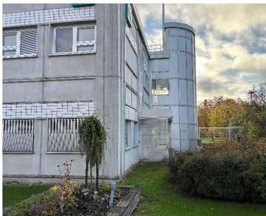
Kuva 2. Vapaudenpolun puoleisen päädyn porrashuone.
