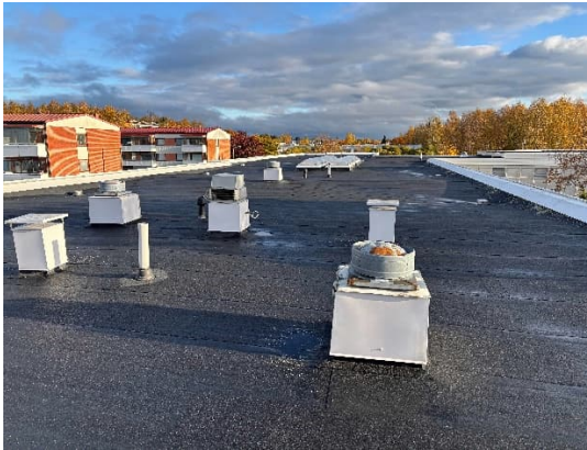
Kuva 4. Alkuperäisen osan vesikatto yleensä.
