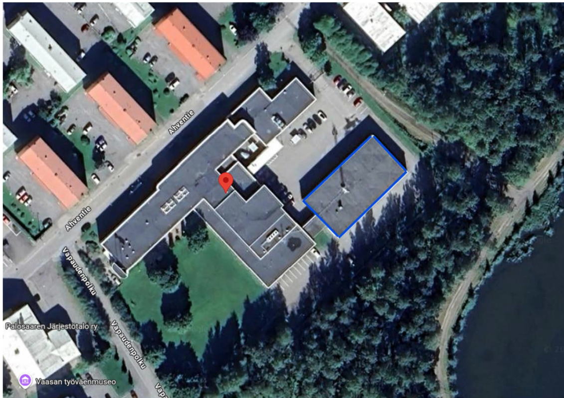
Kuva 1. Kohde kuvattuna ilmast (googlemaps). Sinisellä korostettu myöhemmin rakennettu autohalli.
