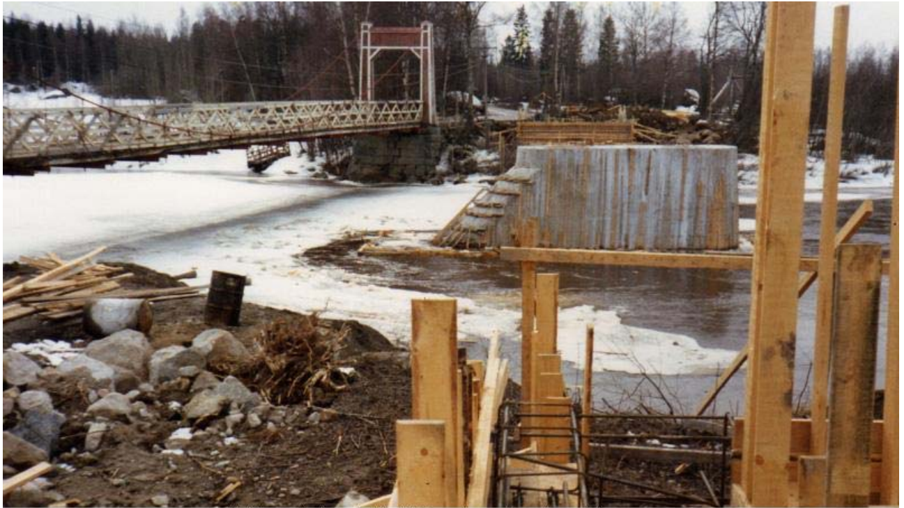
Kolkin uusi silta tekeillä 1977 vanhan sillan alapuolelle.
