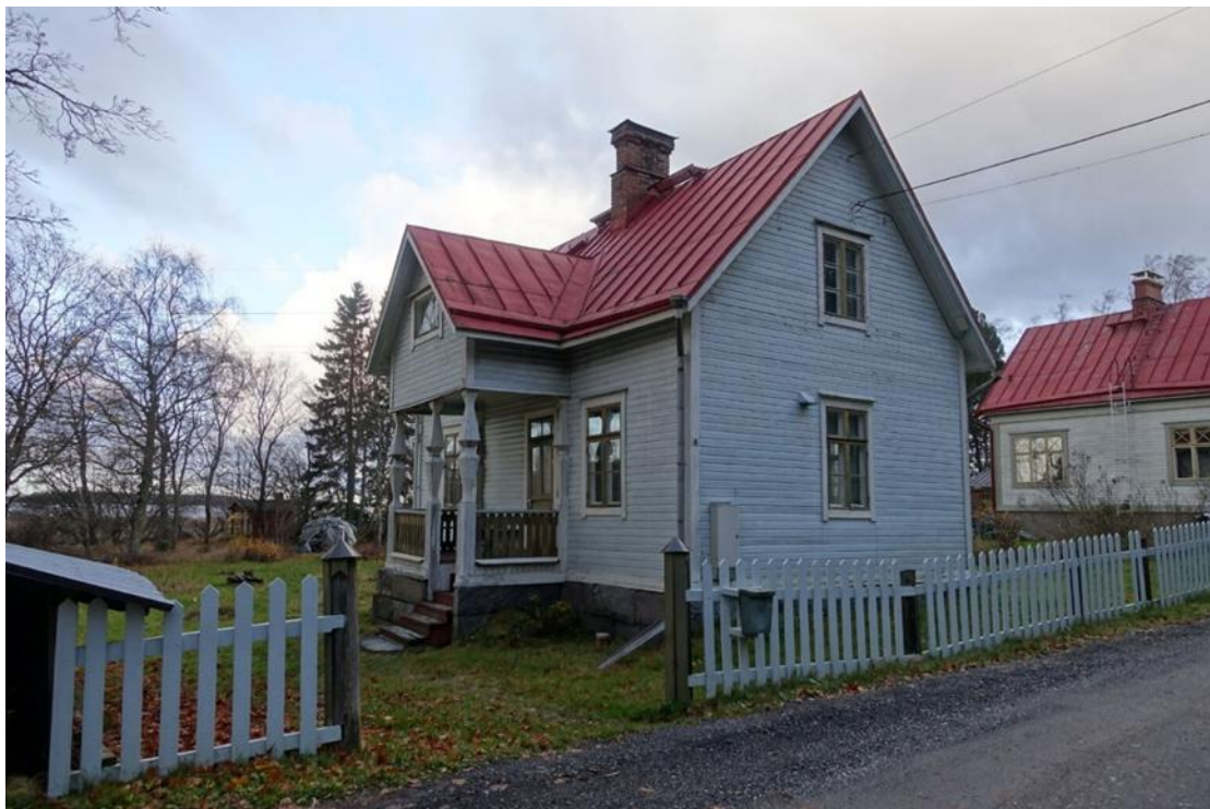
Huvudbyggnaden på Månviksgatan 8 fotograferad hösten 2020.
