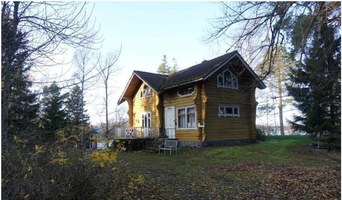
Villa Stenfors, jonka taka-alalla uimahuone/sauna syksyllä 2020.
