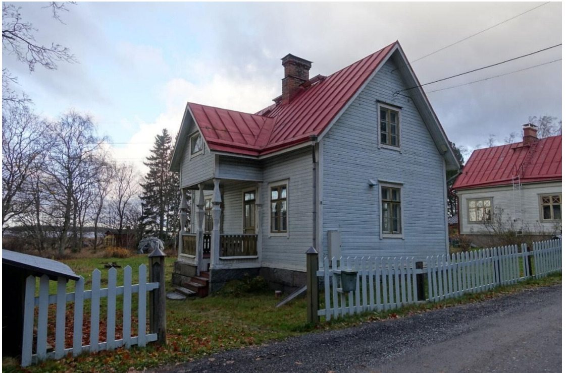
Kuulahdenkatu 8:n päärakennus kuvattuna syksyllä 2020.
