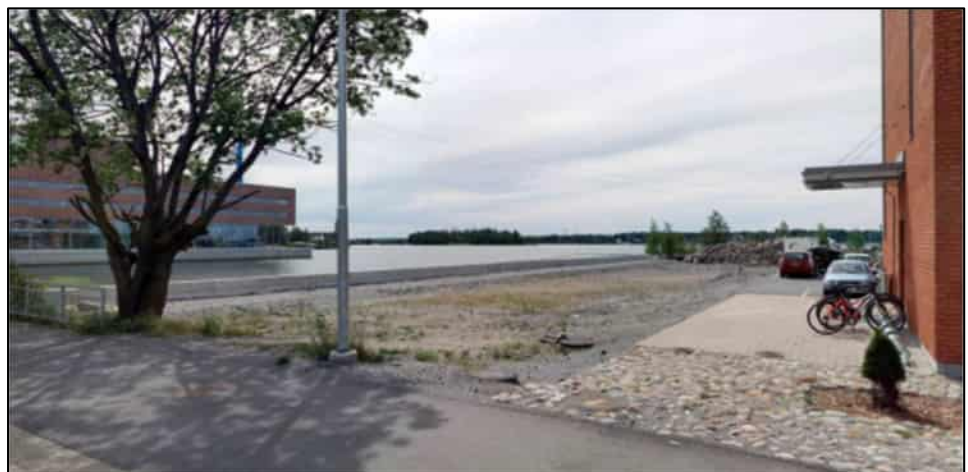
Kuva 9. Näkymä Palosaaren sillalta. SmartGrid tulee sijaistsemaan rantamuurin suuntaisena keskivaiheilla valokuvaa. Takavasemmalla näkyy loppuvuodesta 2014 valmistunut Vaasan Sähkön toimistorakennus.
