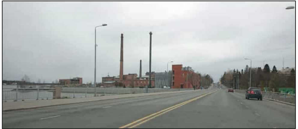
Kuva 7. Innotalon kortteli Palosaaren sillan pohjoispäässä. Alueen takana näkyy Finlaysonin tehdas. EnergyLab laboratorio-toimistorakennus sijaitsee kadun varrella.
