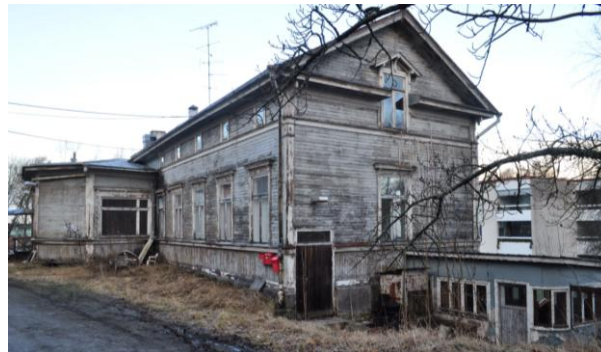
Kuva 8. Saippuan kiinteistön entinen konttori-asuinrakennus ja portinvartijan rakennusosa kuvattuna vuonna 2015. Valokuvaote selvityksestä Palosaaren teollisuusalue, Rahkola ja Saippuan alueet, inventoinnin päivitys /Outi Orhanen, 2016.
