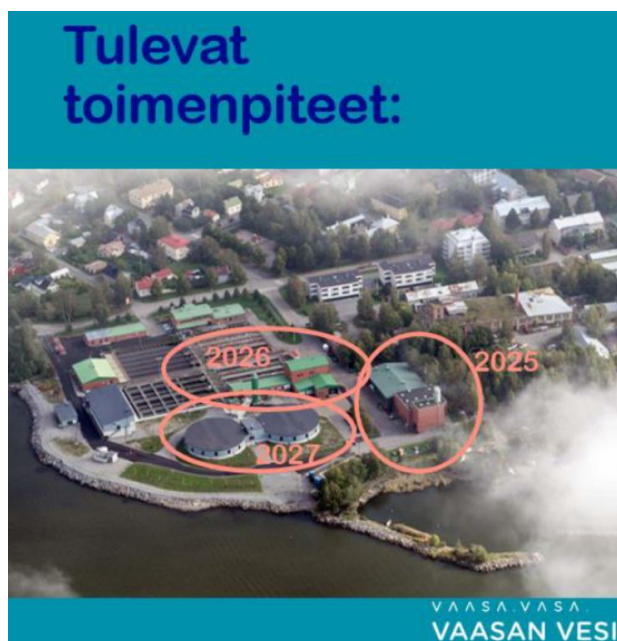
Kuva 24. Åtgärder för luktreducering vid Påttiska reningsverket 2025–2027.
