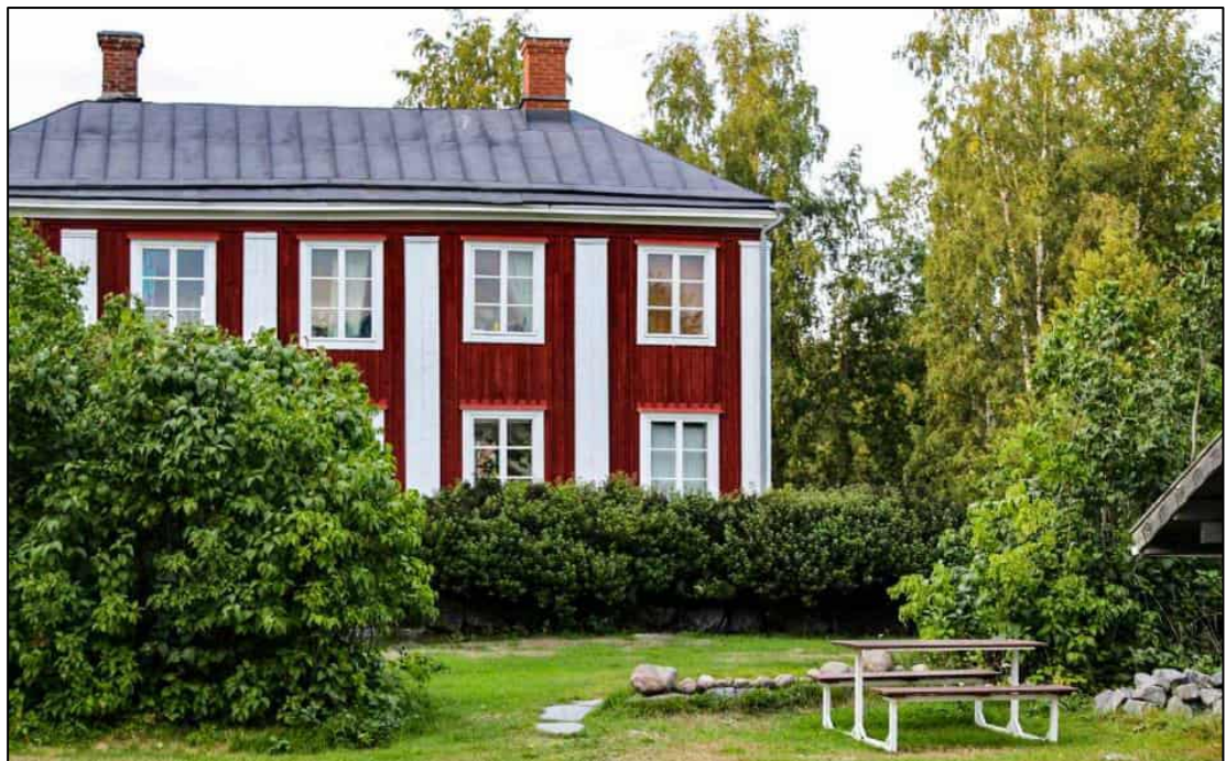
Alkulaa etelän suunnasta (Internet: vaasa.fi, Alkula and the Forest Foreman Park, 2026)
