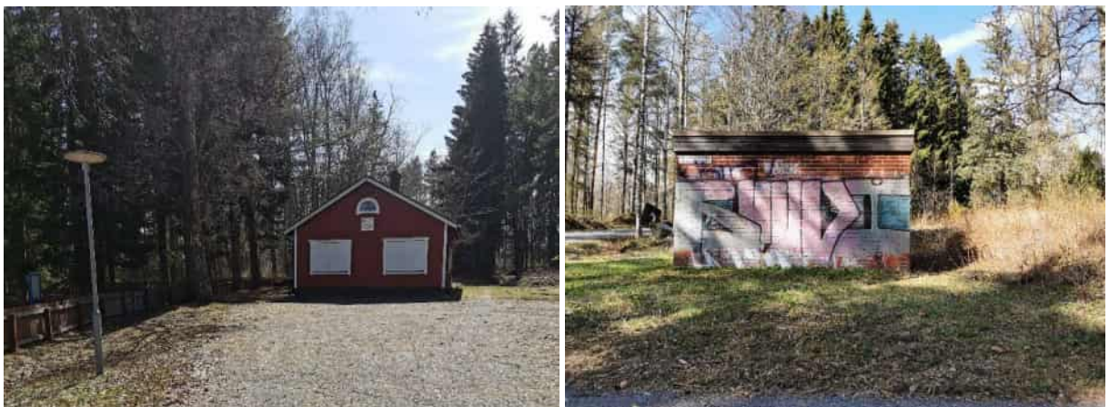
Kuvat: Avoimen päiväkodin rakennus (purettu) ja muuntamo.
