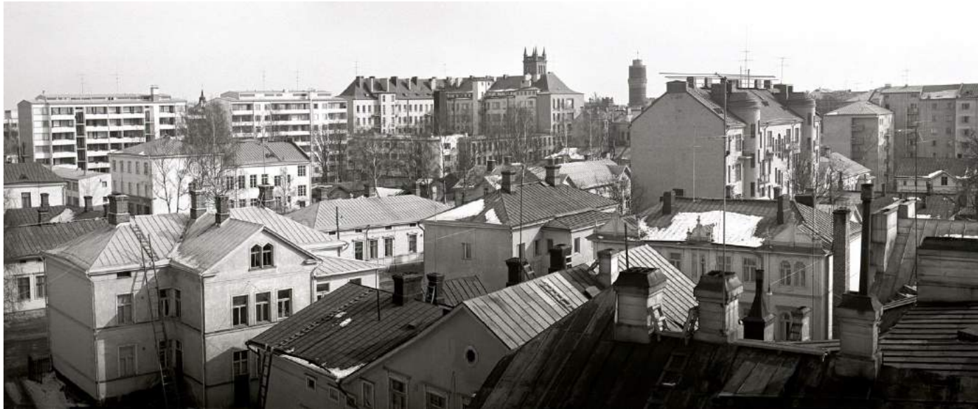
Näkymä Hietasaarenkatu 1:n katolta, huhtikuu 1964, Gunnar Bäckman.
