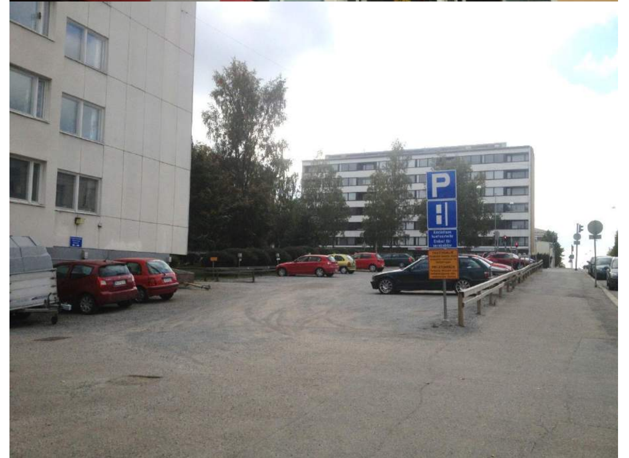
Yllä: Julkisivujen huonoa kuntoa.
