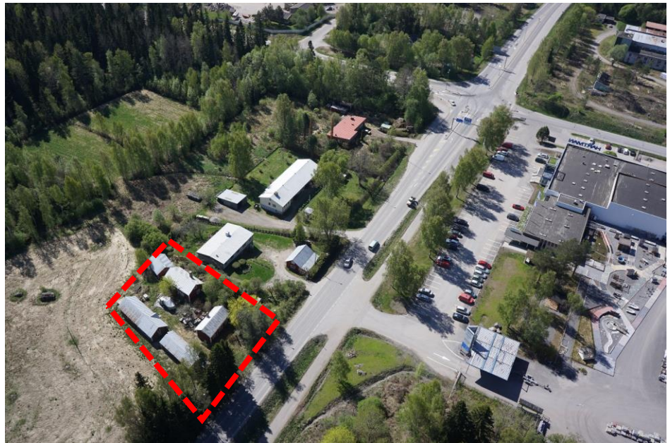
Kuva 23. Kanavasillantie 14 pihapiiri. Lähde: Rakennusinventointi Liisanlehdon asemakaava-alueella (Vaasan kaavoitus 2018).
