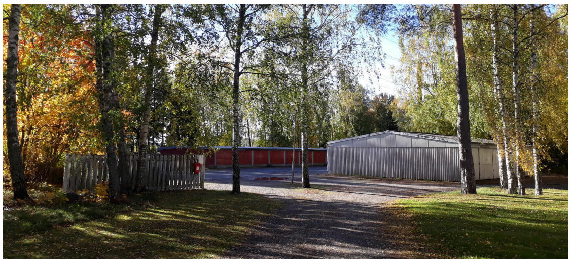
Frilundintien asuintalojen piha-alueita kuljettaessa voimalinjan suuntaan, näkymässä punainen autotalli (7) ja Frilundintie 7 tontilla oleva vaalea hallirakennus (6), suluisissa tunnuksilla rakennukset on merkitty sivun 21 ilmakuvaan
