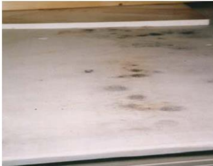
Bild 1 Mögelfläckar på pappen (kartongen) Bild 2 Rinningsmärken på skivorna
