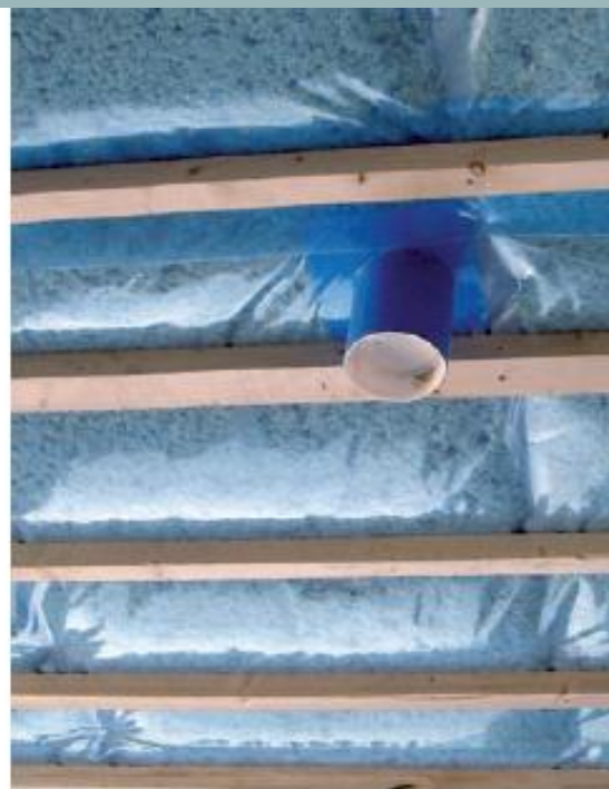
Höyrysulun läpivienneissä käytetään läpivientikappaleita.
