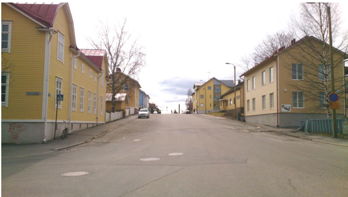
Wolffintien yleisilme kaavamuutosalueen lähiympäristössä on matala ja perinteisen rakentamistavan mukainen.
