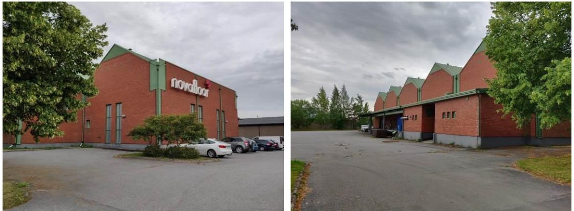
Novafloors byggnad, bilden tagen från Industrigatan (tvänster) och från Karla-vägen (höger)
