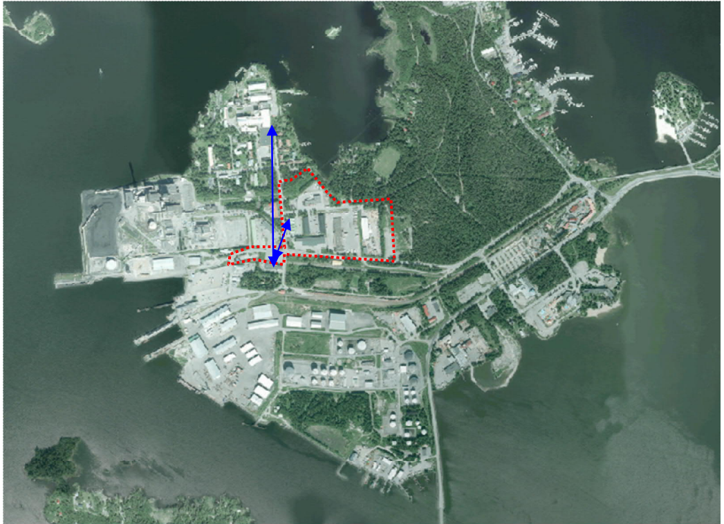
Ilmakuva Vaskiluodosta, suunnittelualue liittyy nykyistä selvemmin suurimittakaavaiseen satama- ja teollisuusrakentamiseen kaavan mahdollistaman rakennusoikeuden toteutuessa kokonaisuudessaan, nykyisiä alueen toimintoihin liittyviä liikennöintitarpeita esitetty sinisillä nuolilla
