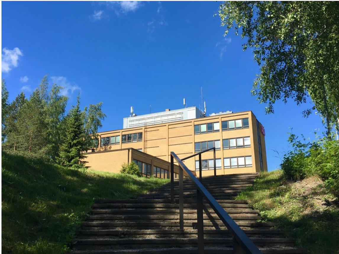
Bild 10. SO-byggnaden sedd för den nedre gårdens parkeringsområde.
