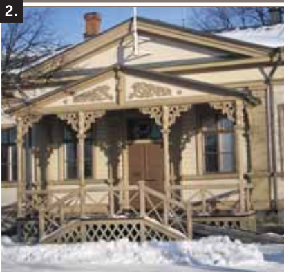
Komentajan asuinrakennus ulkoa ja sisältä.
