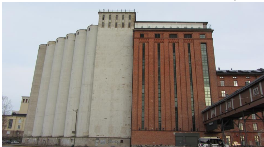
Betonisiilot rannan puolelta.
