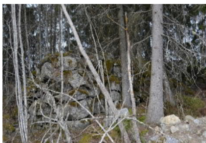
Stenmuren har blivit i skuggan av trädbeståndet. Framför stenmuren finns en jordvall som uppkommit vid grävning för kommunalteknik.
