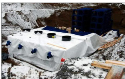
Bilden visar byggande av en underjordisk fördröjningsbehållare dvs. dagvattenceller, med en fördröjningsvolym på 300 m 3
