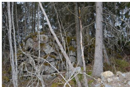
Kivimuuri on jäänyt puustoon varjoon. Kivimuurin edessä on kunnallisteknisen kauvuun synnyttämä maavalli.
