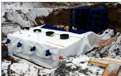
Kuvassa rakennetaan maanalaista viivytyssäiliötä eli hulevesikennostoa, jonka viivytystilavuus on 300 m 3 .
