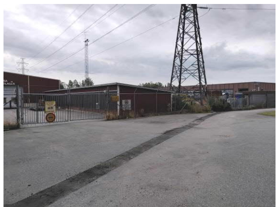
Teollisuus- ja varastorakennuksia Kaarlentien itäpäästä
