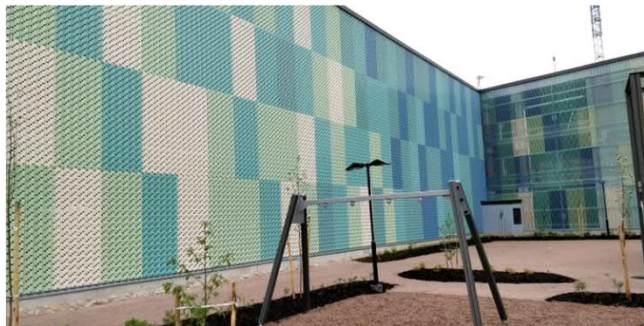
Topaasiparkki, Vantaa, YIT Rakennus Oy, Lai-Teräs Mäkinen Ky
