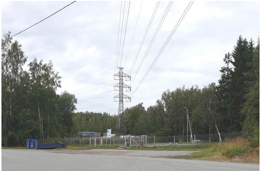
Inhägnad hundpark under kraftledningarna på den norra sidan av Karlavägen.
