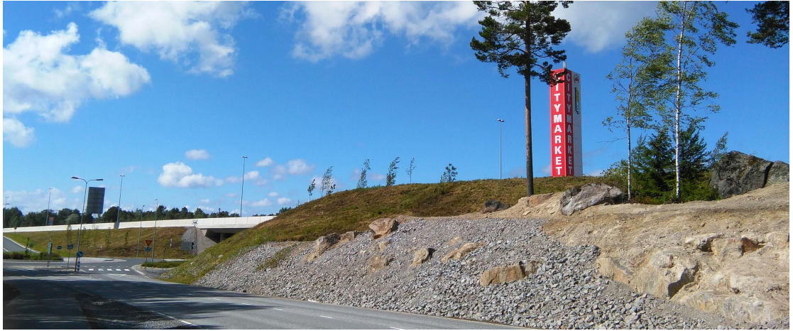
Otsontien alikulkusilta Sepänkylän suunnasta saavuttaessa. Kuva: Kaavoituksen arkisto
